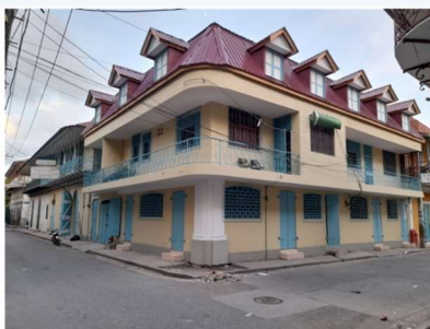
Photo 2 : Bâtiment à la rue 16
