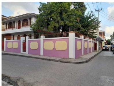
Photo 4 : Clôture réhabilitée à la rue 20
