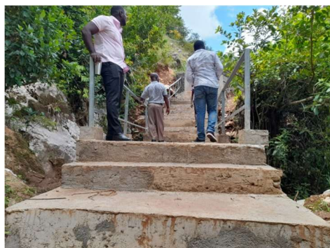
Photo 15 : Escalier de la Chute de Cotard
