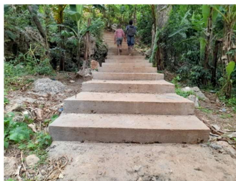
Photo 14 : Escalier de la Chute de Cotard
