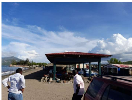
Photo 16 : Vue du hangar à Camp Louise
