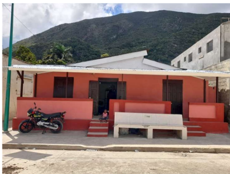
Photo 10: Ravalement de façades autour de la place
