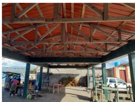
Photo 17 : Charpente réhabilitée à Camp Louise
