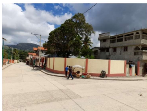
Photo 11 : Ravalement de façades autour de la place de Dondon
