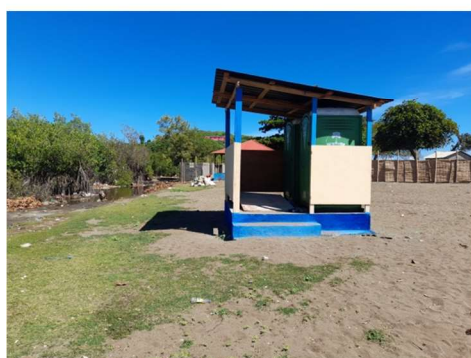
Photo 19 : Cabine installée pour les toilettes sur la plage Caramel
