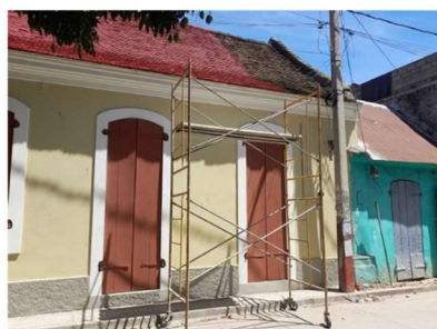
Photo 3 : Travaux au niveau de la toiture
