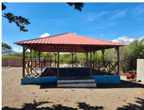
Photo 18 : Hangar sur la plage Caramel
