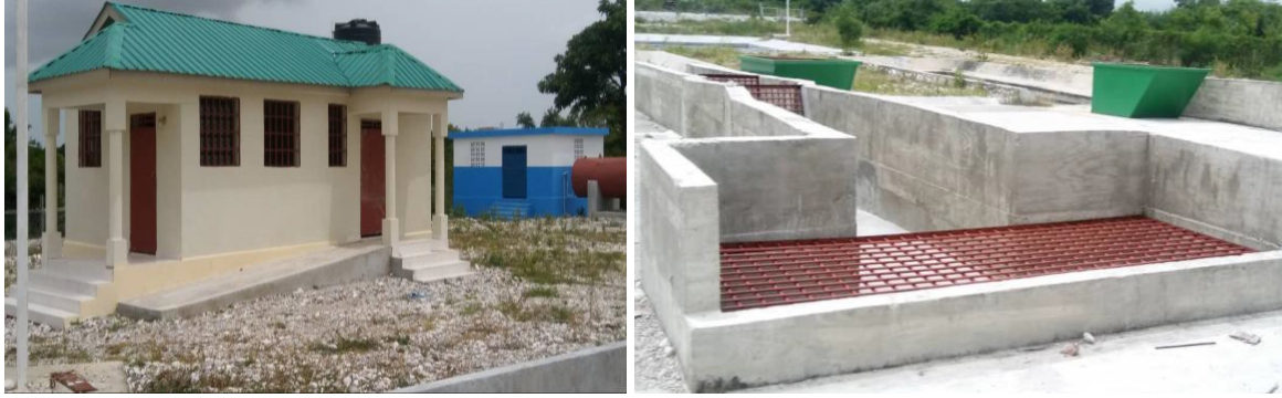
FIGURE 7: BATIMENT ET OUVRAGE DE DEGRILLAGE DE LA STATION DE TRAITEMENT
