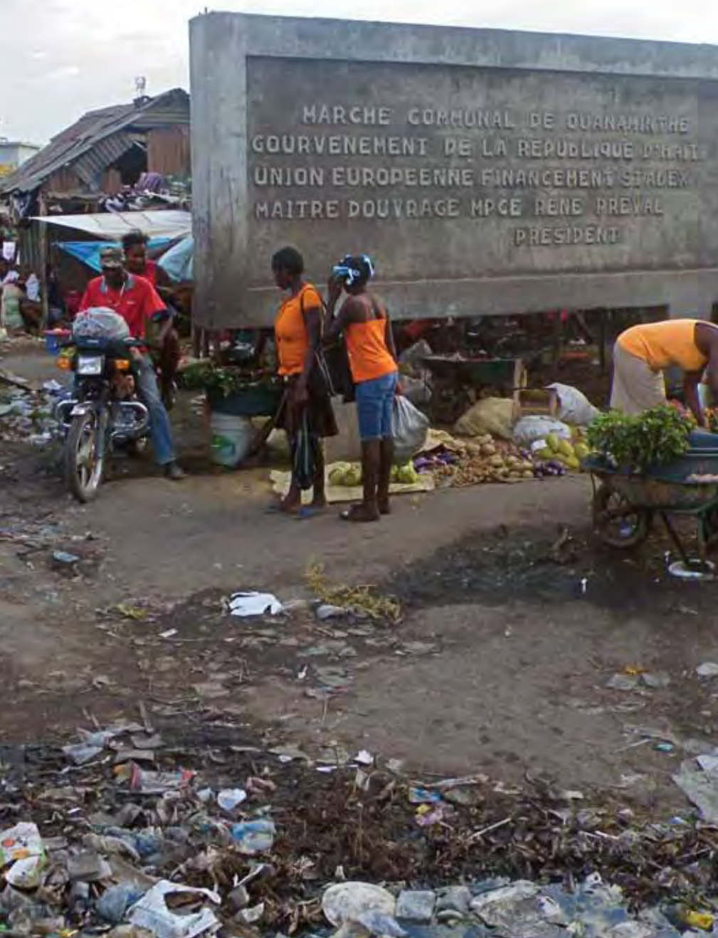
Dégradation du marché public de Ouanaminthe.
