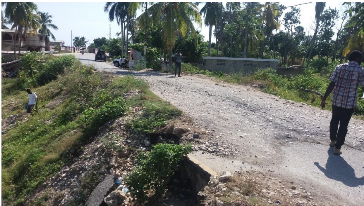
Détérioration de la chaussée dû au problème de drainage
