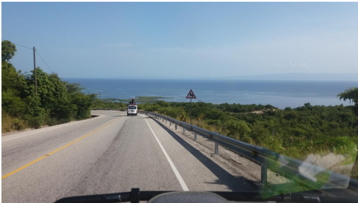
Existence de la signalisation
