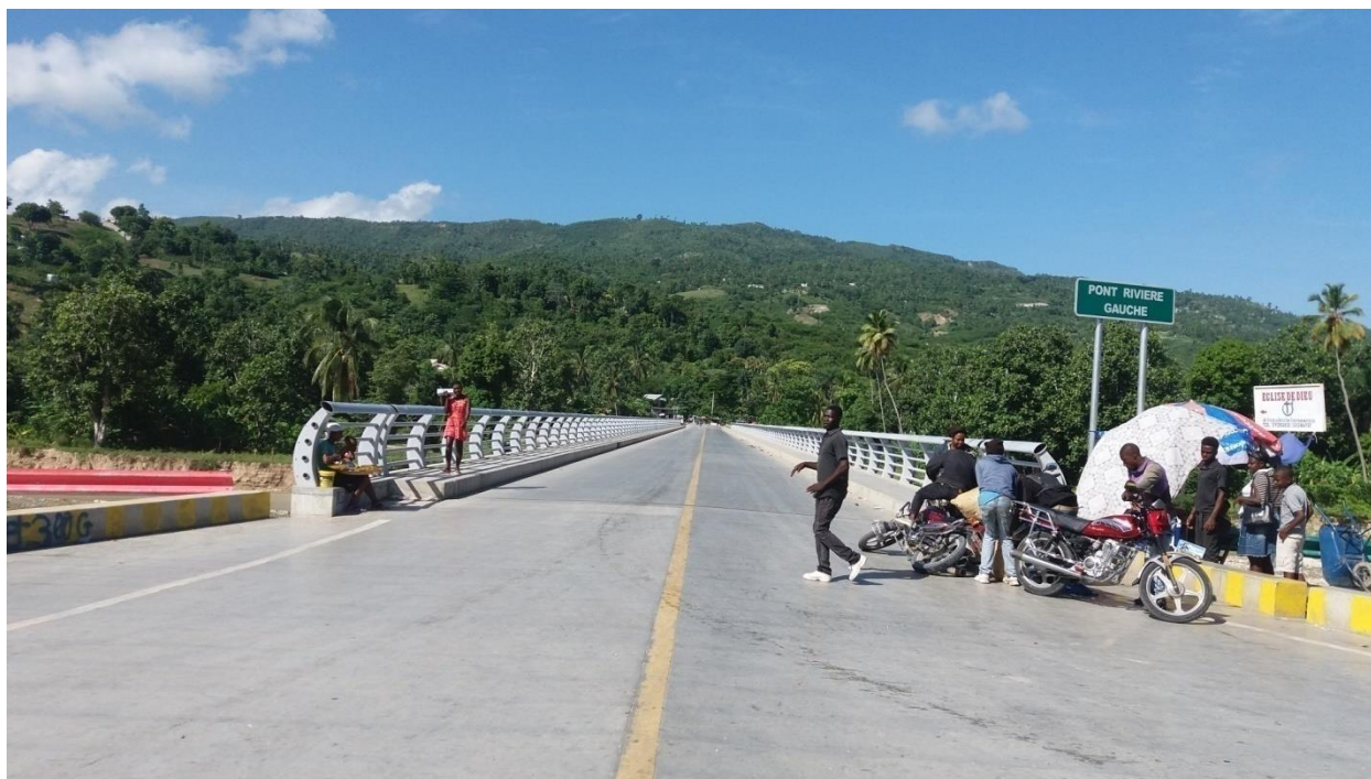
Entrée du pont de la rivière gauche
