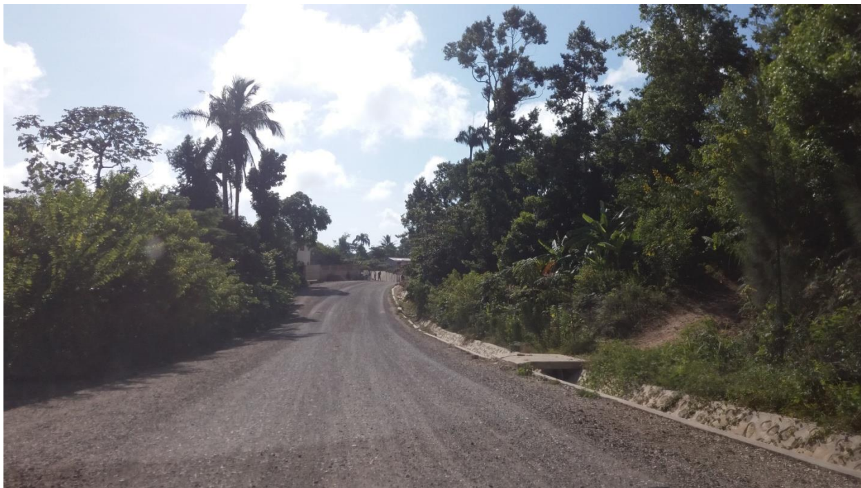
Une section des tronçons non bétonnées
