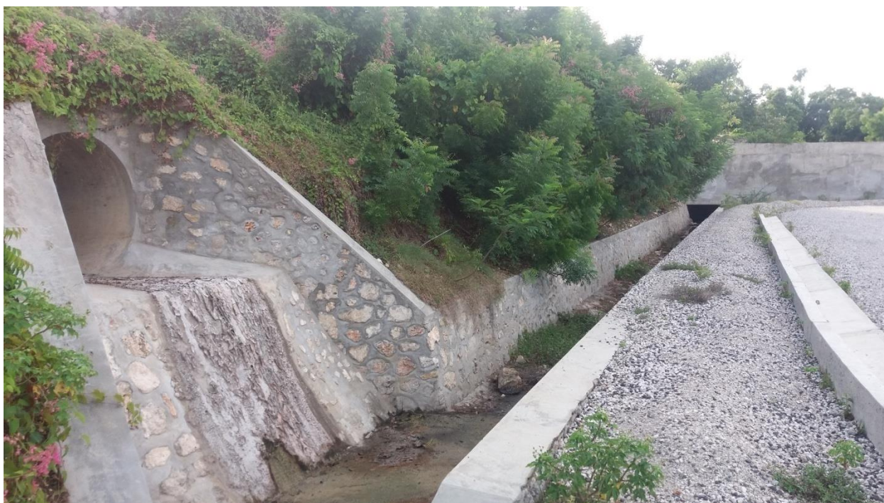
Drainage de la gare de Miragoâne
