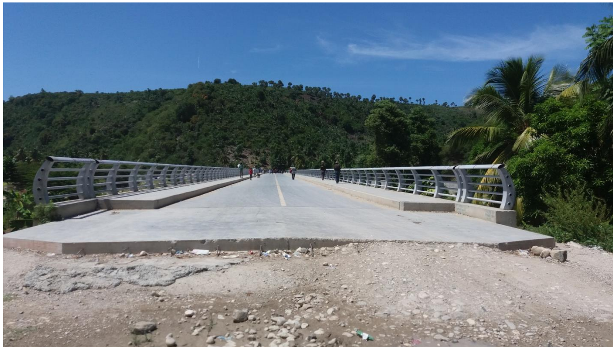
Le pont de Marigot (Péredo)
