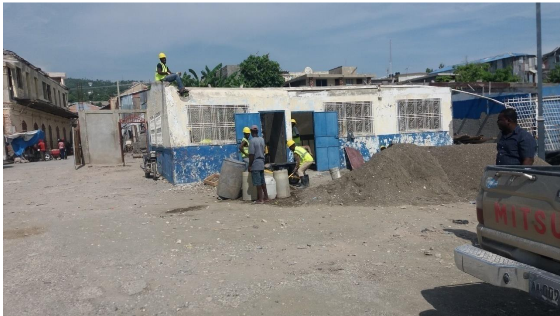
Construction du bureau de douane de Jérémie
