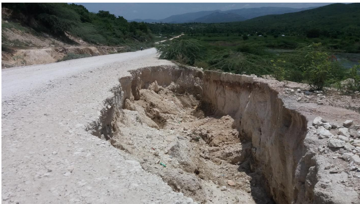
Effondrement des couches de base du tronçon Petite-Rivière/Petit-Trou de Nippes
