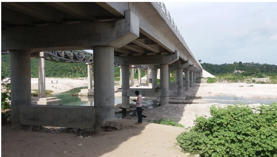
Infrastructure du pont Voldrogue
