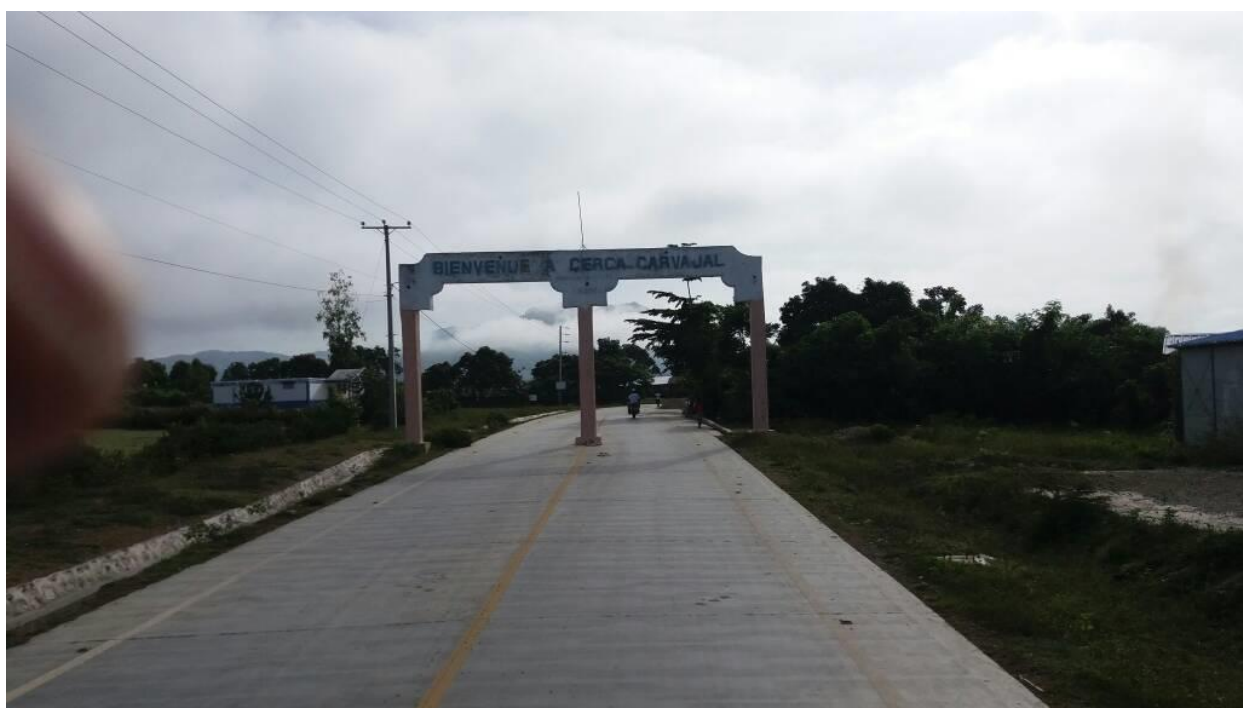
Route de Cerca-Cavajal en béton hydraulique
