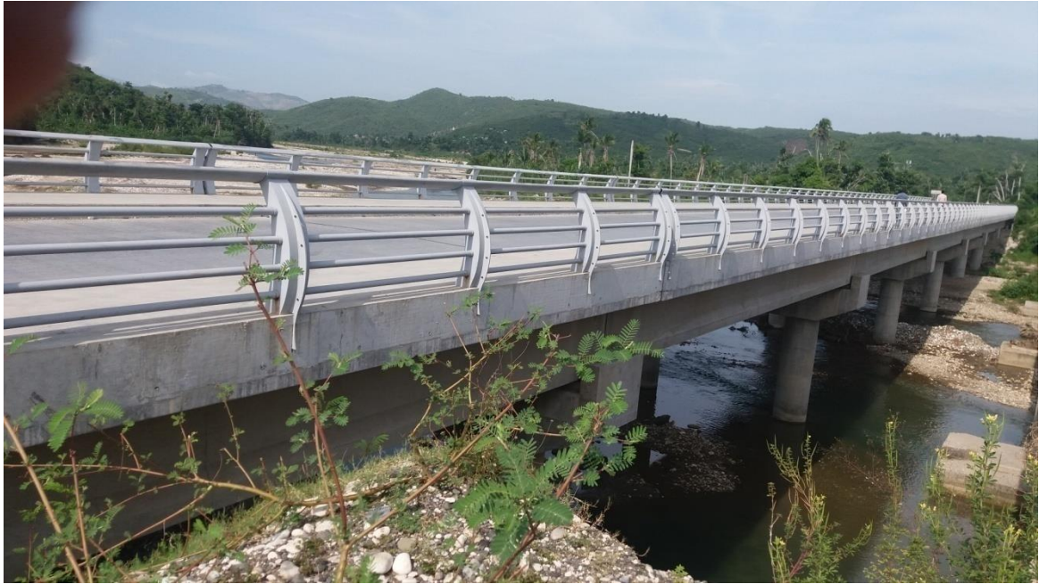
Pont Voldroque de profil
