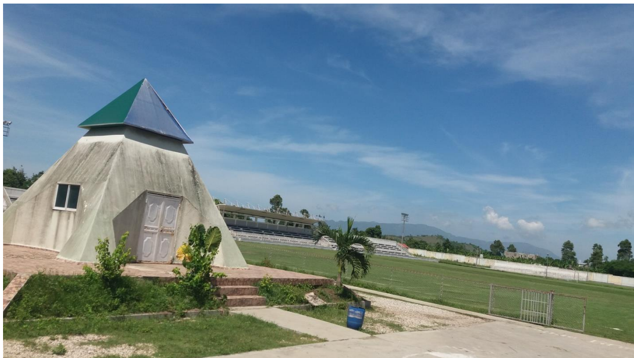
Infrastructure du parc sportif de Milot
