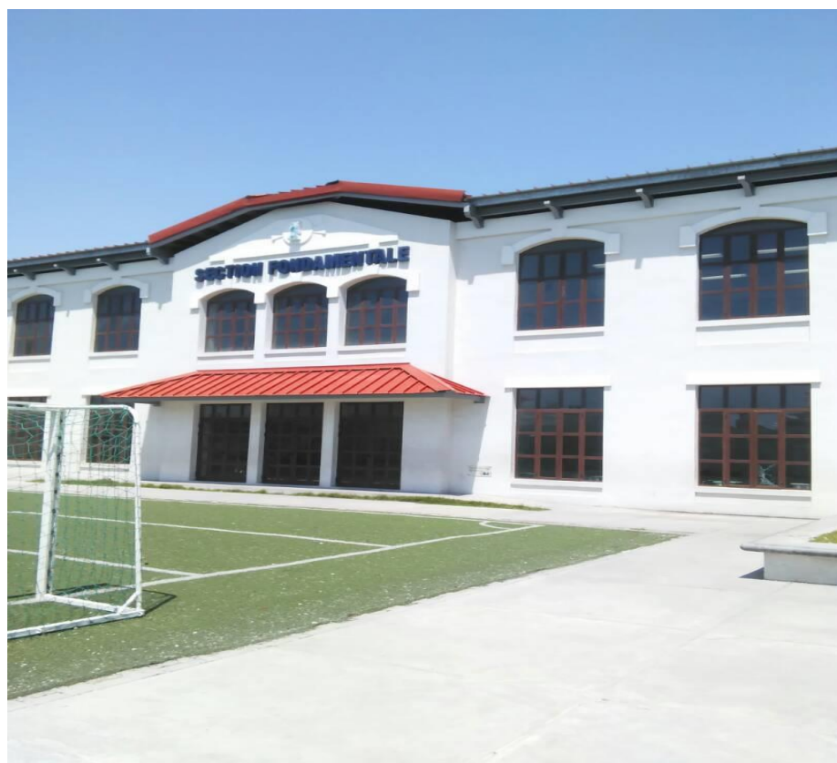
Façade nord du lycée Toussaint Louverture
