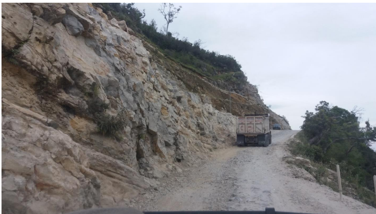
Le terrassement (Fanm Pa Dra)
