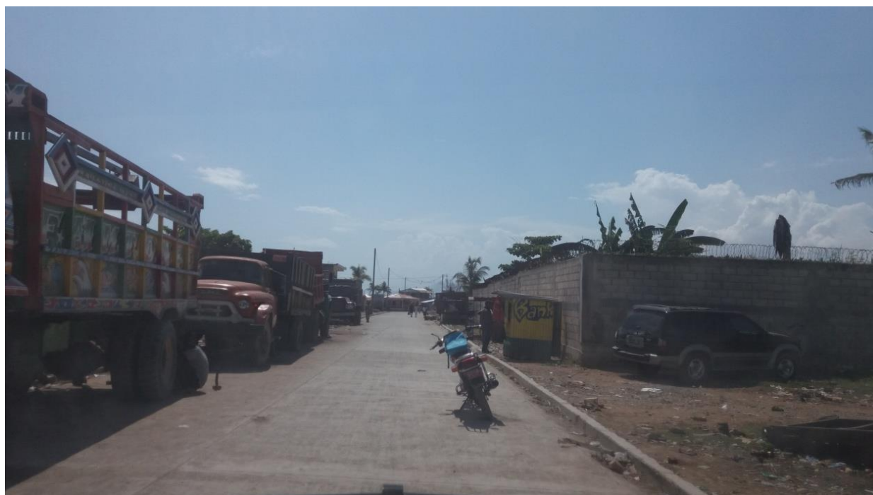
Vue d'une rue bétonnée inachevée
