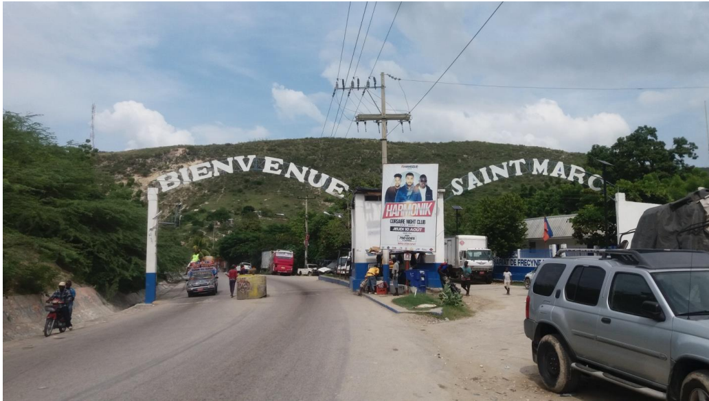
Réhabilitation de la route Frécyneau Saint-Marc
