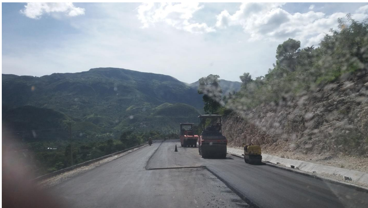
Travaux de réhabilitation de la route Ennery-Cap-Haitien.
