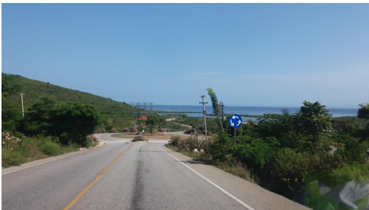
Existence de la signalisation 2
