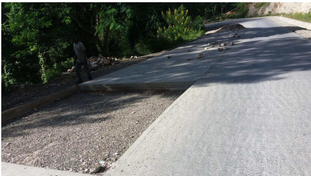
Béton hydraulique inachevé
