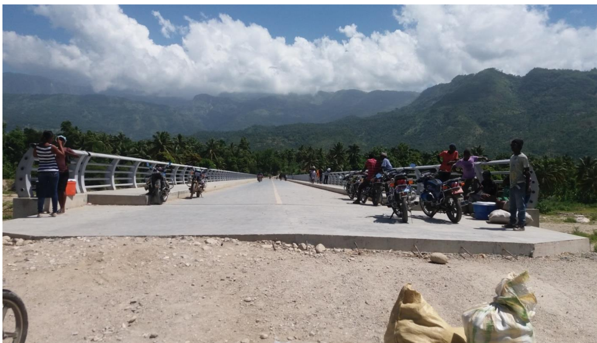
Le pont de Marigot (Péredo)
