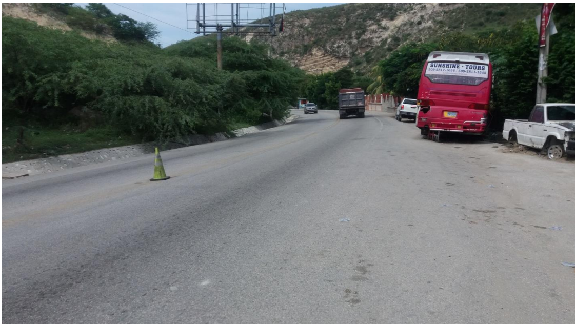
Réhabilitation du tronçon de route Saint-Marc/Gonaïves
