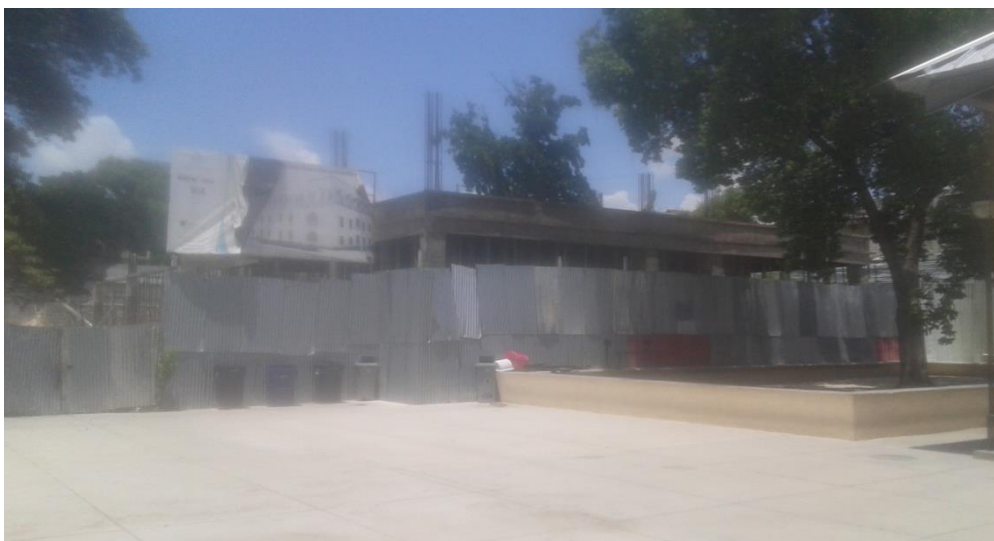
Partie inachevée du lycée
