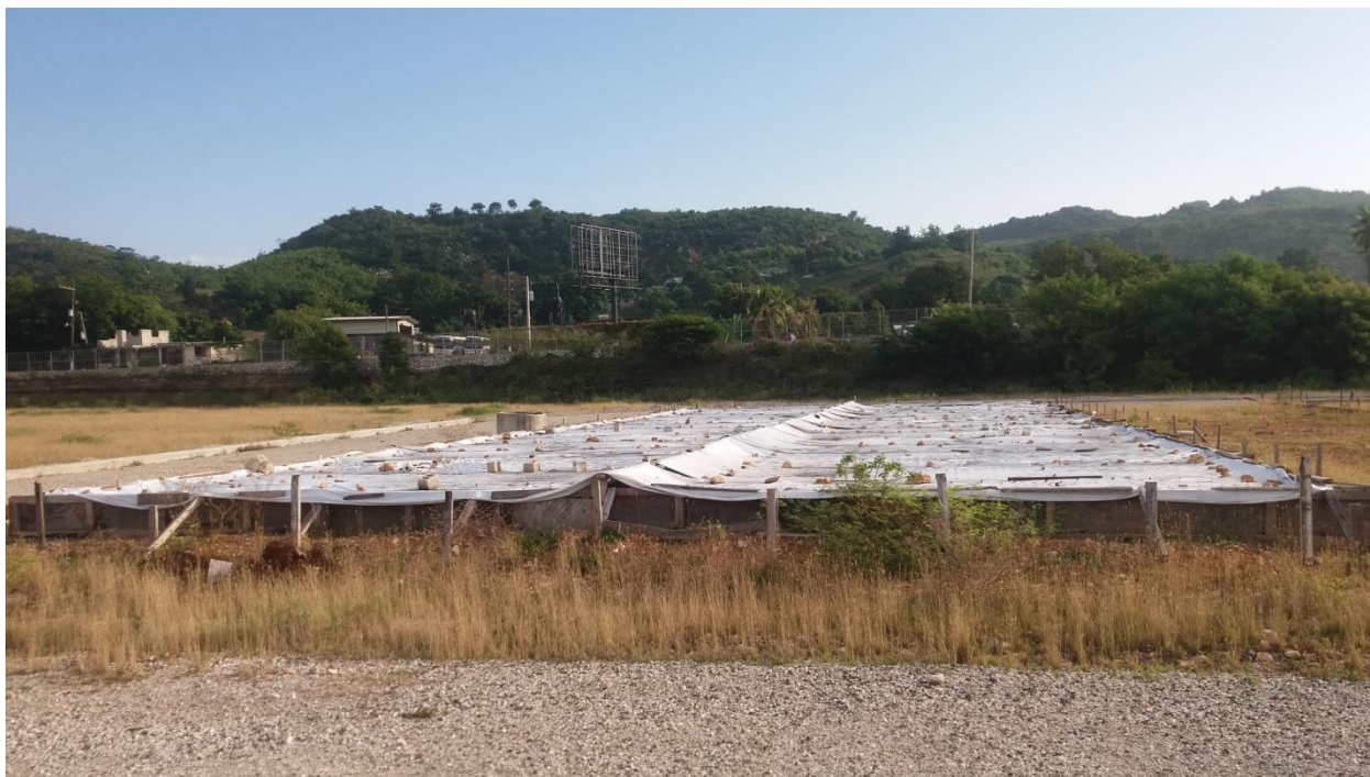
Parquet ferrailé et couvert pour éviter la rouille
