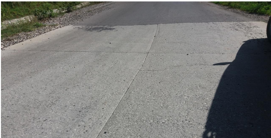
Connexion de la chaussée en béton hydraulique et celle en béton bitumineux
