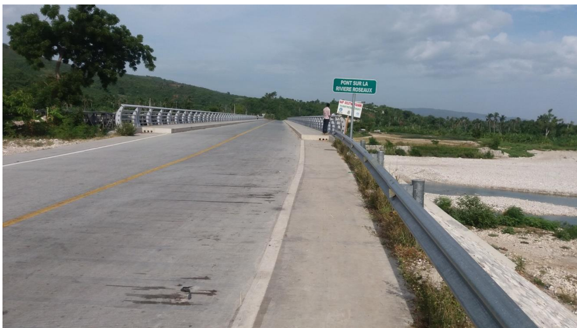
Entrée du pont Roseau
