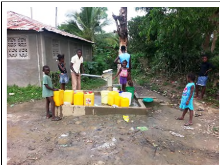
Photo 4.6: Forage avec pompe manuelle à Perches
