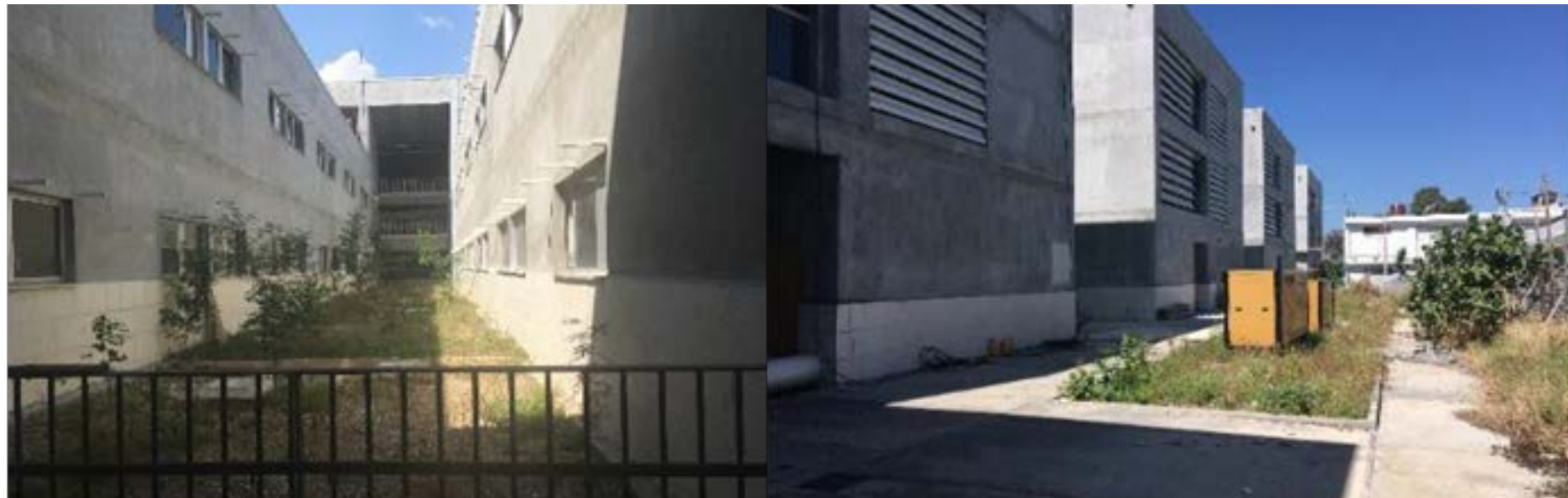
Courette entre Bâtiments G et H HALLÉE extérieure côté nord vue vers l'ouest
