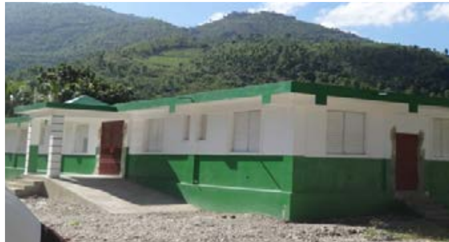
Construction du centre de santé de Baradères
