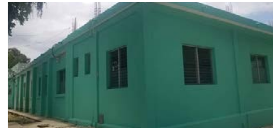
Extension de la maternité du CDI de l'Anse à Veau (finalisé)
