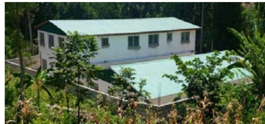
Construction du centre de Saut du Baril (Petit Trou de Nippes) (finalisé)
