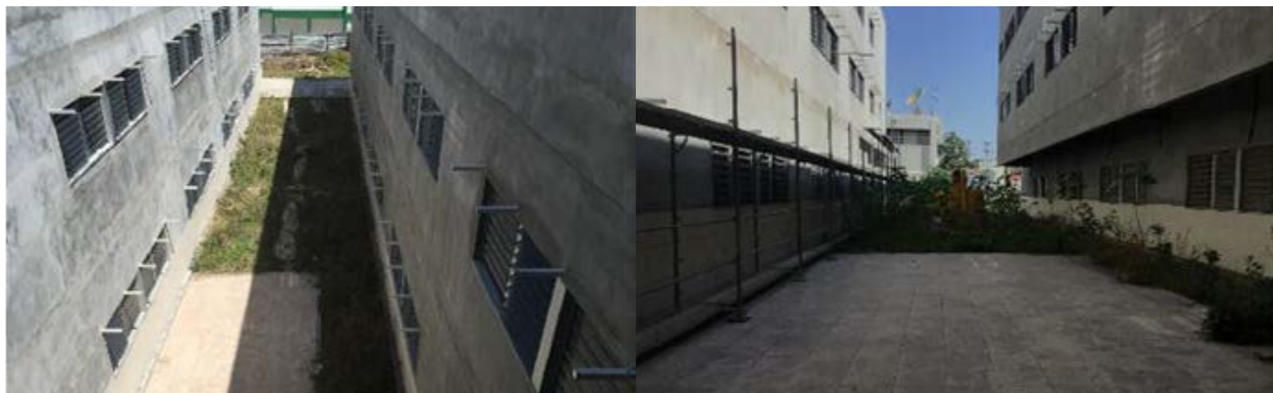
Courette entre Bâtiments C et D Courette entre Bâtiments D et E
