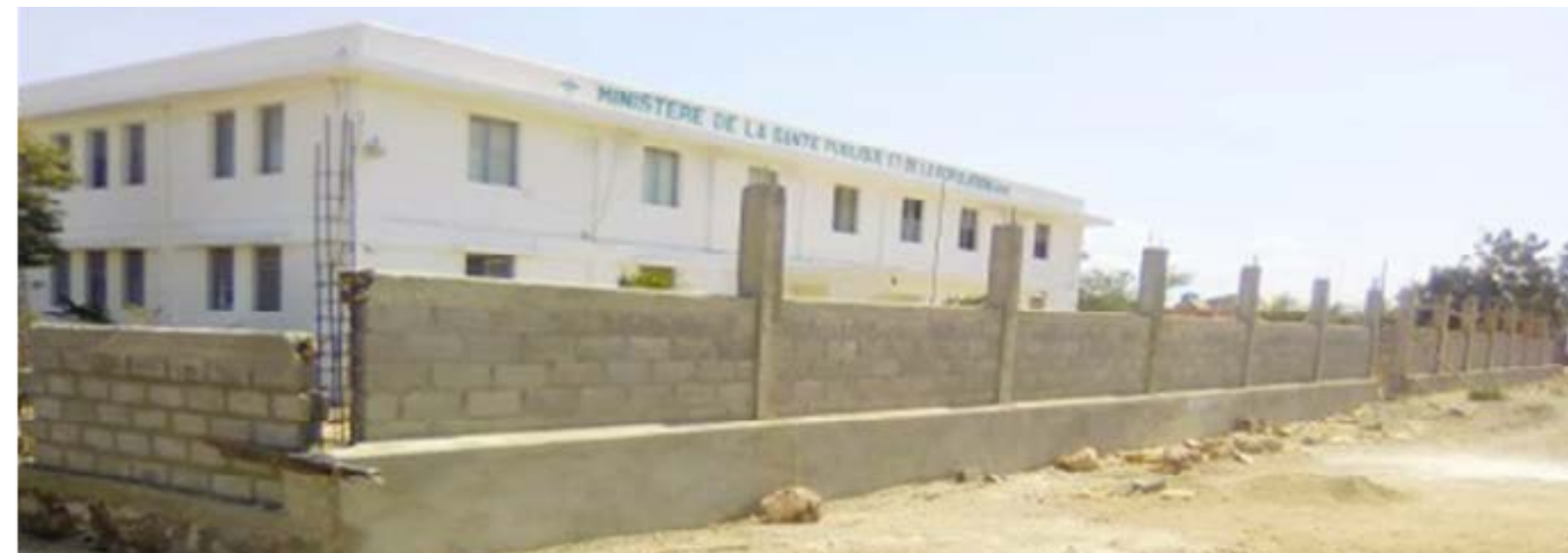
Construction de la clôture du bureau départemental du Nord-Est
