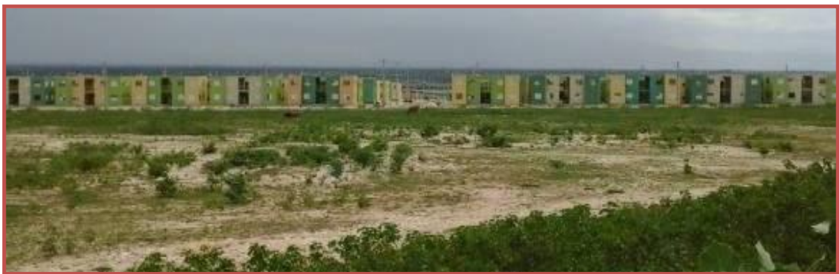
FIG. 26: En haut le stade de football de Canaan (en construction) et en bas les maison construites pour les IDP du séisme de 2010, les deux se trouvent dans les zones de liquéfaction.
