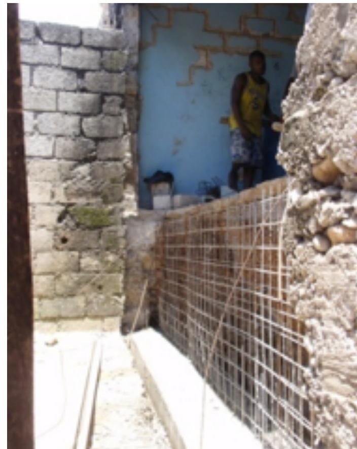
Dessin 71 :Le mur en cours de réalisation
