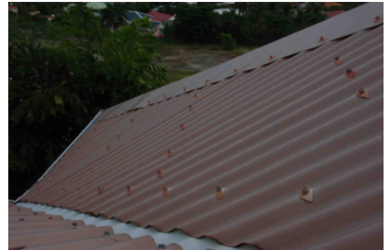
Dessin 89 : Toiture fixée par des tirefonds
