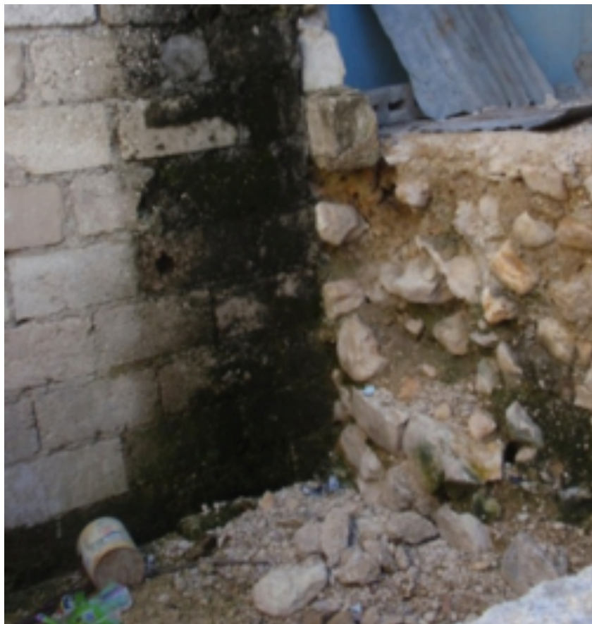
Le dénivelé existant
