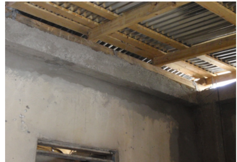
Dessin 87 : Toiture renforcée
