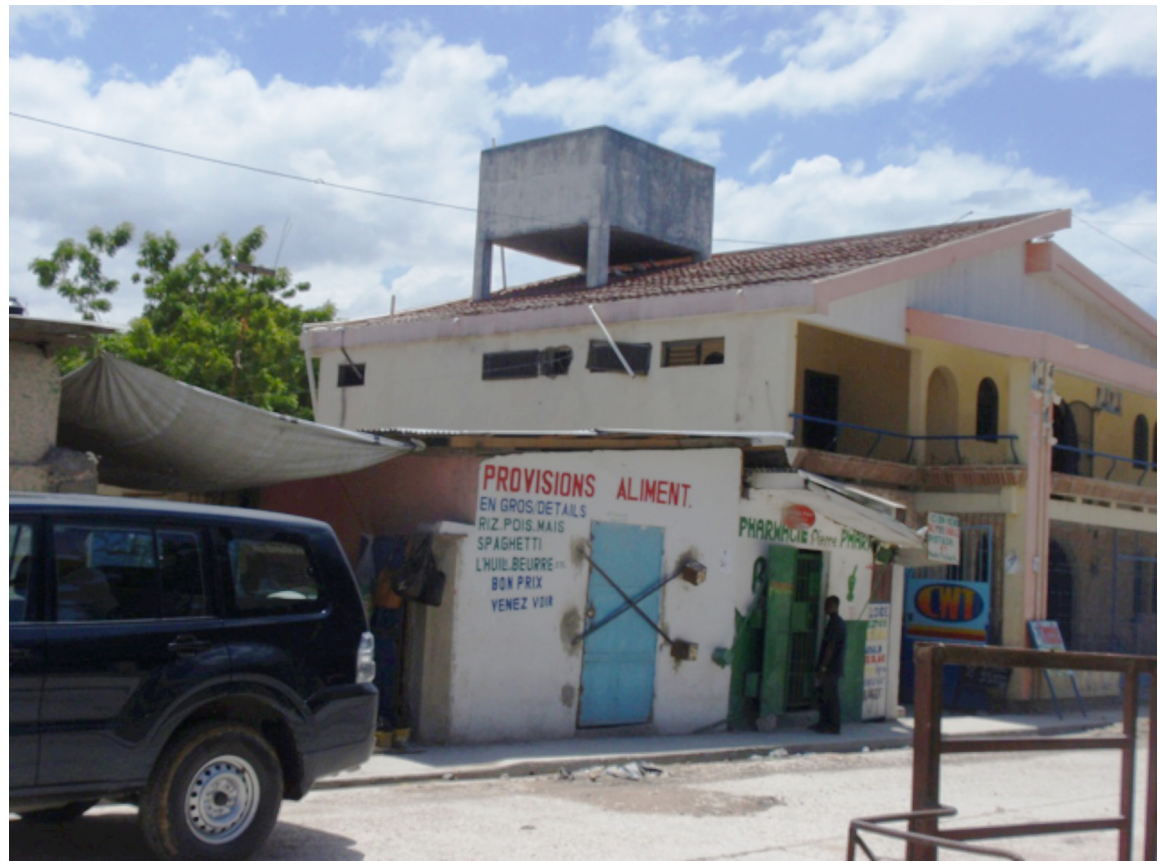
Dessin 31: Citerne placée sur un toit
