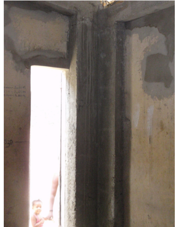
Dessin 44 : Exemple de chaînages verticaux réalisés
