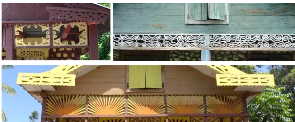
Figure 6.5.12.3- 1_Frises d'imposte de la galerie : photos
