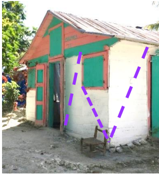
Figure 6.5.5.4.7- 1_Contreventement des panneaux d'angles avec fenêtres : photos d'une maison à La Vallée-de-Jacmel
