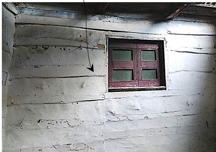
Figure 6.5.6.1- 2_Maçonnerie de petites pierres, méthode « étranglé » : photos de maisons vernaculaires
