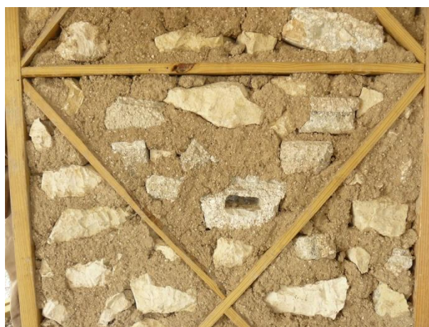
Figure 6.5.6.2- 1_Remplissage en gravats de récupération : photos de mise en œuvre
