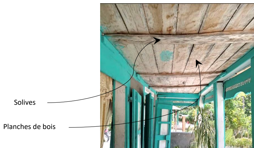
Figure 6.5.12.1- 1_Plafonnement de la galerie sous la toiture principale : photo
