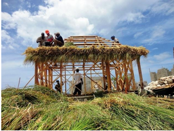
Figure 6.5.13.2- 1_Mise en œuvre des couvertures en fibres végétales : photos
