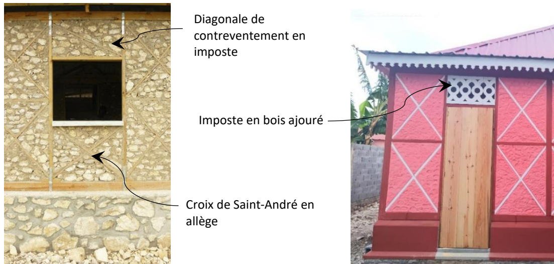
Figure 6.5.5.4.6- 1_Contreventement des allèges et impostes des ouvertures : photos de mise en œuvre
