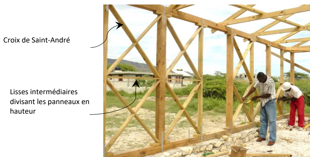
Figure 6.5.5.4.3- 3_Contreventement par croix de Saint-André des panneaux subdivisés : photo de mise en œuvre
