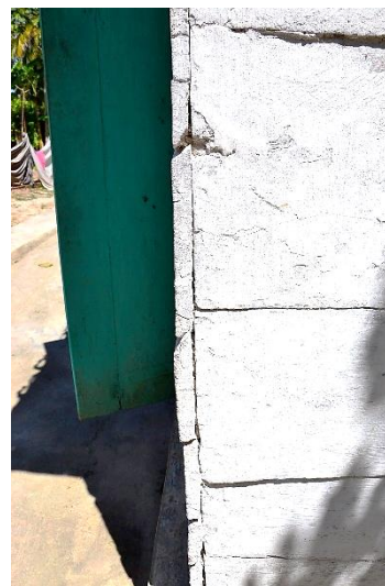
Figure 6.5.5.4.4- 1_Bardage de planches assurant le contreventement de l'ossature : photos d'une maison à La Vallée-de-Jacmel, localité de Morne-à-Bruler
