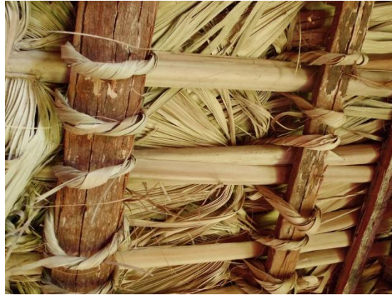
Figure 6.5.13.2- 1_Mise en œuvre des couvertures en fibres végétales : photos
