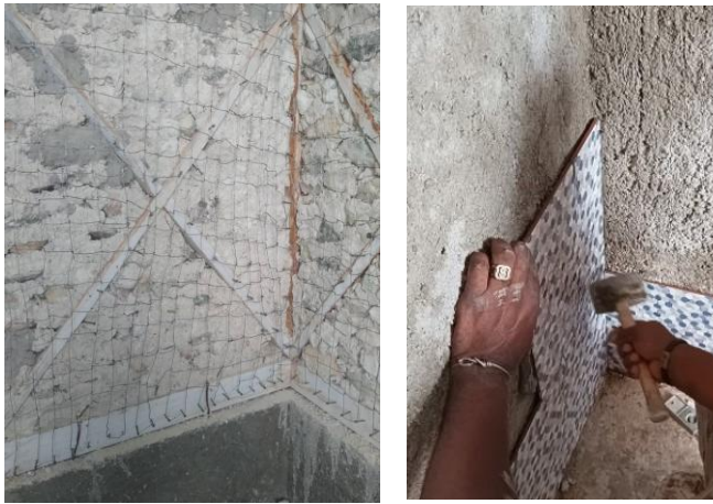
Figure 6.5.8.3- 1_Pose de faïence murale sur treillis métallique : photos de mise en œuvre
