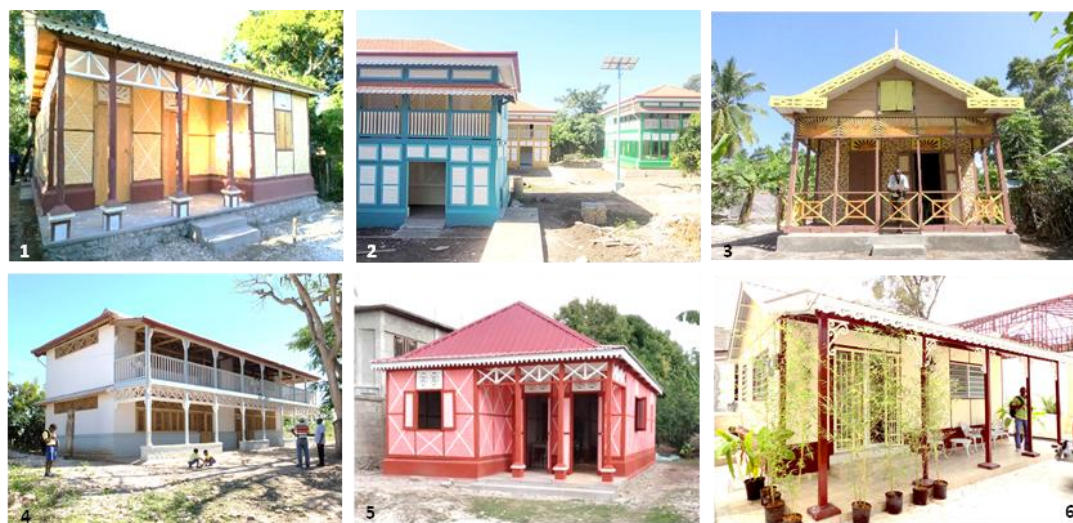
Figure 6.2.1- 2_Diversité des typologies de bâtiments récents en ossature bois porteuse et remplissages ou habillages
