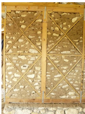
Figure 6.5.6.2- 1_Remplissage en gravats de récupération : photos de mise en œuvre
