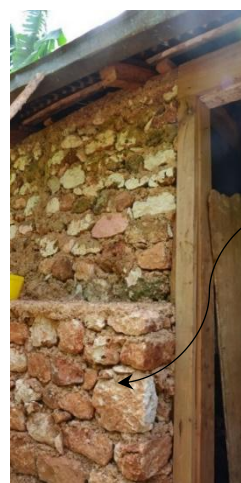
Figure 6.5.2.1- 1_Soubassement en pierres en applique « miray » : schéma en coupe et photo de mise en œuvre
