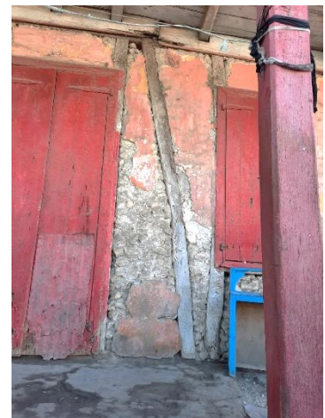
Figure 6.5.5.4.3- 1_Contreventement par diagonales toute hauteur : 3D et photo d'une maison ancienne à Jacmel
