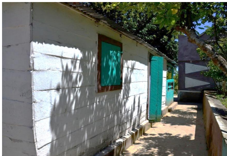
Figure 6.5.5.4.4- 1_Bardage de planches assurant le contreventement de l'ossature : photos d'une maison à La Vallée-de-Jacmel, localité de Morne-à-Bruler
