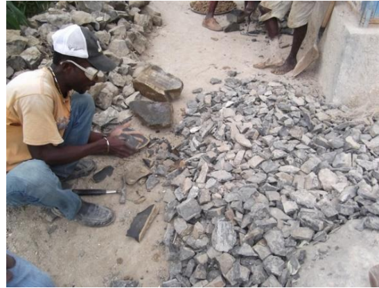
Figure 6.4.3- 1_identification des types de pierres appropriées pour la construction
