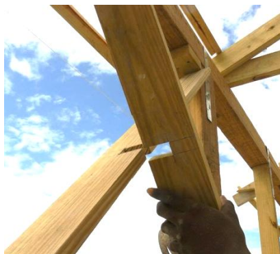
Figure 6.5.5.4.3- 4_Photos de différents assemblages des croix de Saint-André
