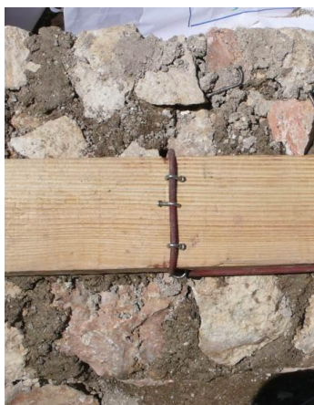
Figure 6.5.3.3.2- 2_Mise en œuvre de la solution 2 - Fers à béton pliés en L dans la fondation, repliés et fixés sur la lisse basse : photo de mise en œuvre et principe de pliage sur la lisse basse
