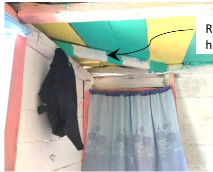
Figure 6.5.5.4.7- 1_Contreventement des panneaux d'angles avec fenêtres : photos d'une maison à La Vallée-de-Jacmel
