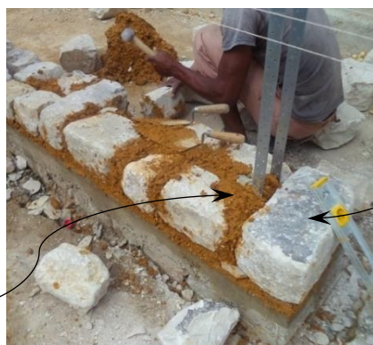
Figure 6.4.3- 6_Appareillage autour des accroches en attente : photo de mise en œuvre
