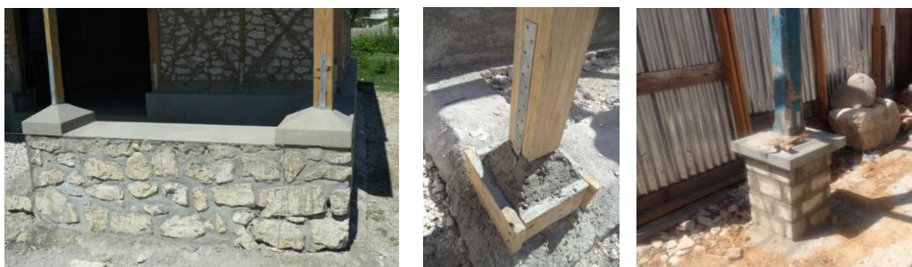
Figure 6.5.2.4- 1_Poteaux de la galerie sur soubassement filant ou plots isolés : photos de mise en œuvre
