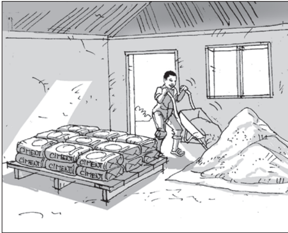
1. Vérifier les matériaux et leur lieu de stockage
