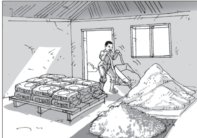
1. Vérifier les matériaux et leur lieu de stockage
