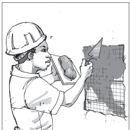
4-C. Appliquer de l'enduit
