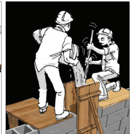
6. Prévoir de couler chaque pièce en une seule phase. Mouiller le béton avec de l'eau le jour suivant.
