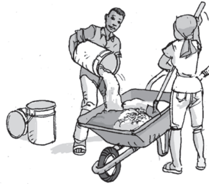
2. Mélanger les matériaux dans un récipient étanche et propre (Cf: brouette, en métal ou plastique)
