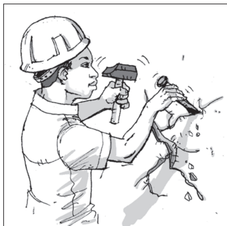
4-A. Enlever l'enduit autour de la fissure de façon à dégager une surface de forme régulière.
