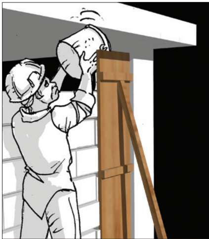
4. Vider le béton par couche et le faire vibrer/ou le tasser avec une tige de fer après chaque couche.
