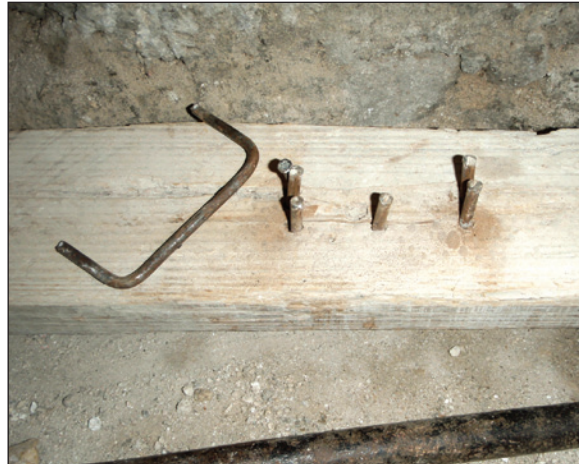
2. Confectionner un «gabarit» pour plier les barres d'acier suivant les longueurs et les angles appropriés.
