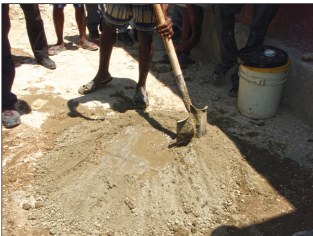
4. Ajouter de l'eau pour faire de petites quantités de mortier et l'utiliser rapidement. 5. Donner au mortier la consistance plastique.
