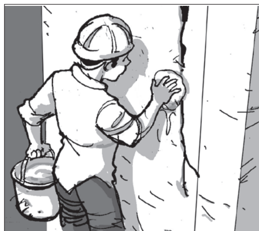
6. Fissure sur la maçonnerie proche de la colonne de béton, du plafond ou du plancher
