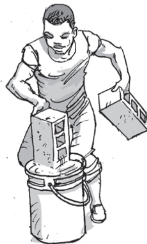
6. Humidifier les blocs avant de les poser.
