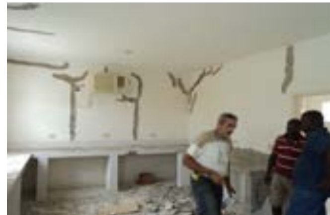
Réhabilitation du PTS de Fort-Liberté Financement: Fonds Mondial
