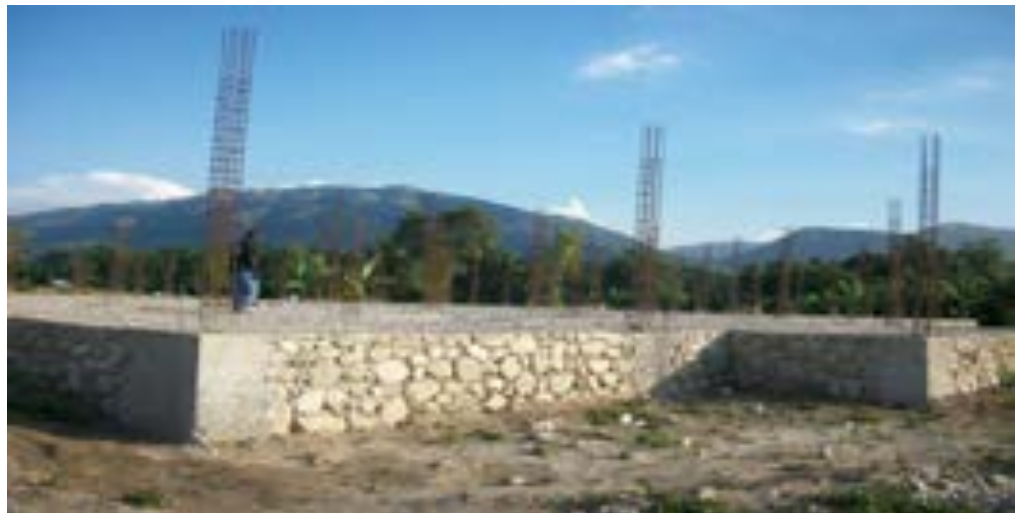
Construction du centre de Santé Croix des Bouquets Financement Trésor Public – (Investissement)
