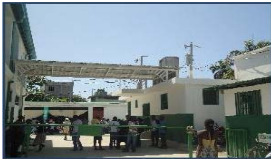
Réhabilitation du Bloc d'urgence
