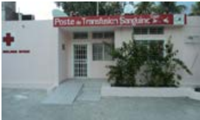
Réhabilitation du PTS des Cayes Financement: Fonds Mondial
