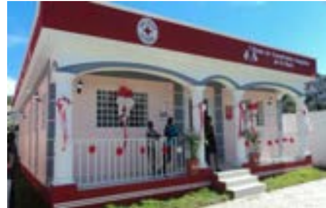
Construction du PTS de St Marc Financement: Croix Rouge Coréenne
