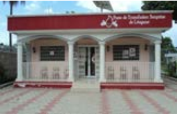
Construction du PTS de Léogane Financement: Croix Rouge Coréenne
