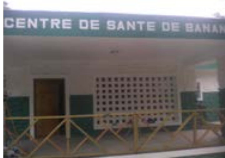
Transformation du dispensaire de Banane (Anse-à-Pitres) Financement: AFD / Arch de l'Urgence
