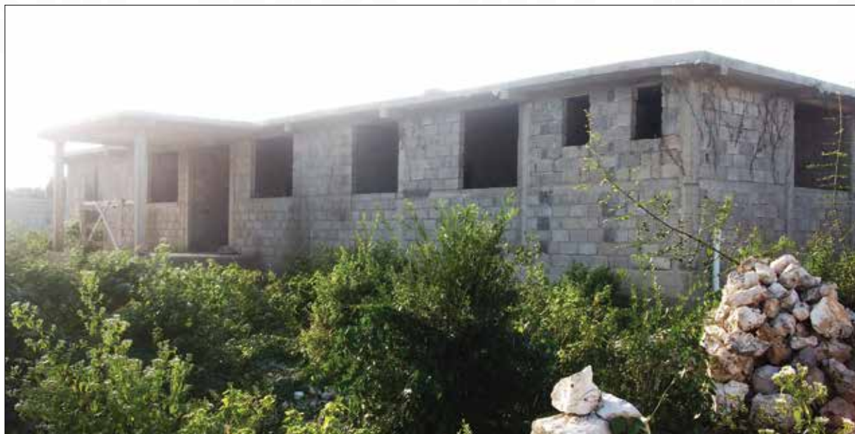
Construction du centre de santé de l'Anse à Masson (Iles Cayemittes)
