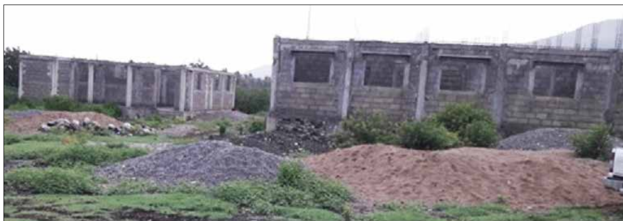
Construction du centre de santé de Tiburon
