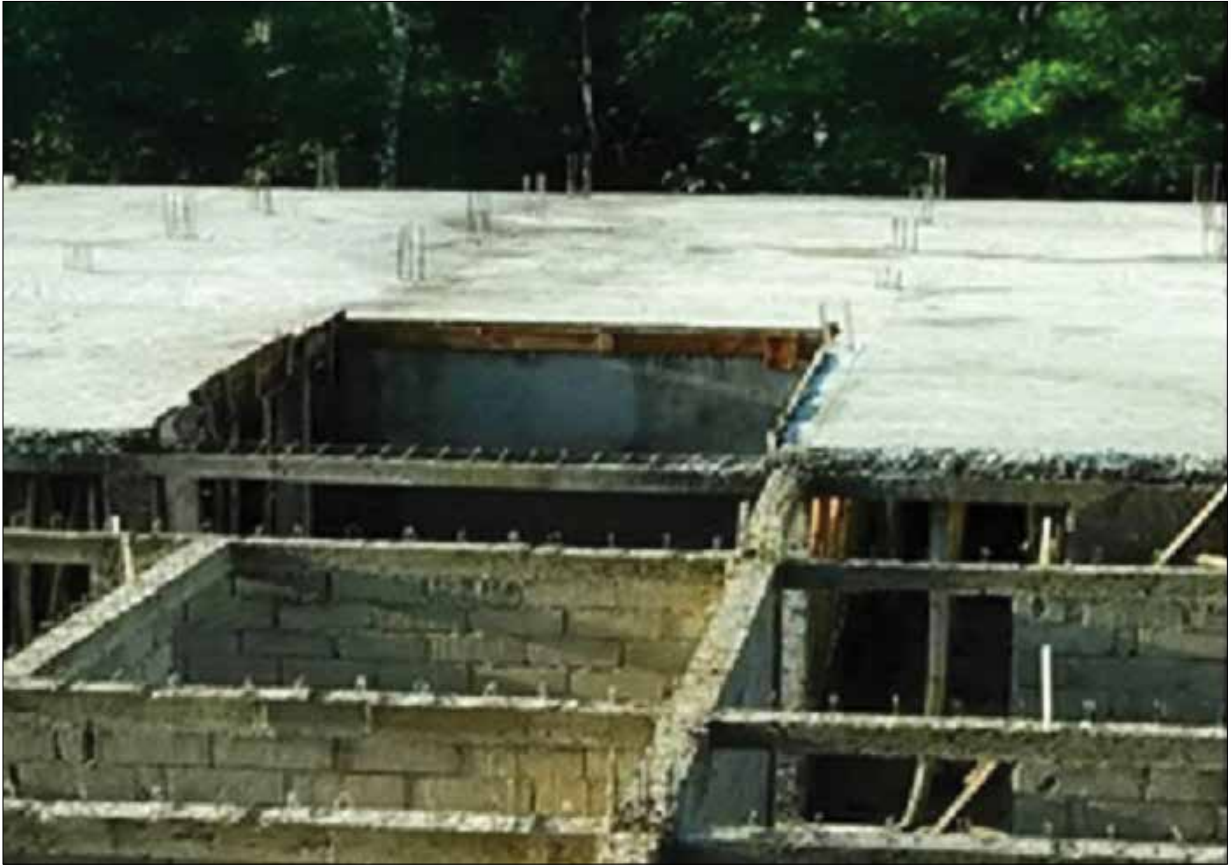
Construction du CSL de Caracol de Grande Rivière du Nord (coulage de la dalle)
