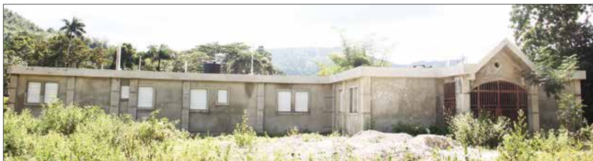
Construction du centre de santé de Plaisance du Sud
