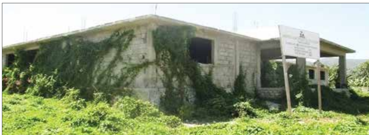
Construction du centre de santé de Croix des Bouquets
