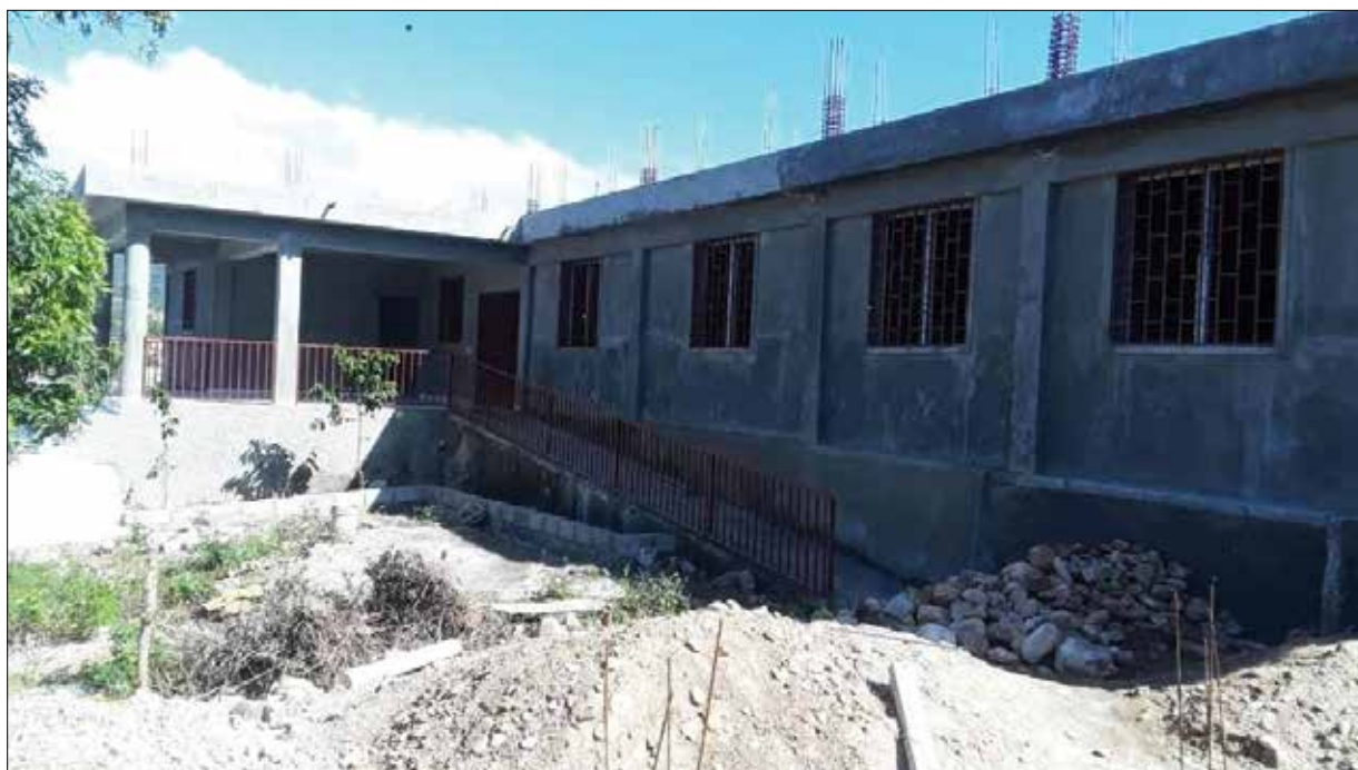
Construction du centre de santé de La Corne (Port-de-Paix)
