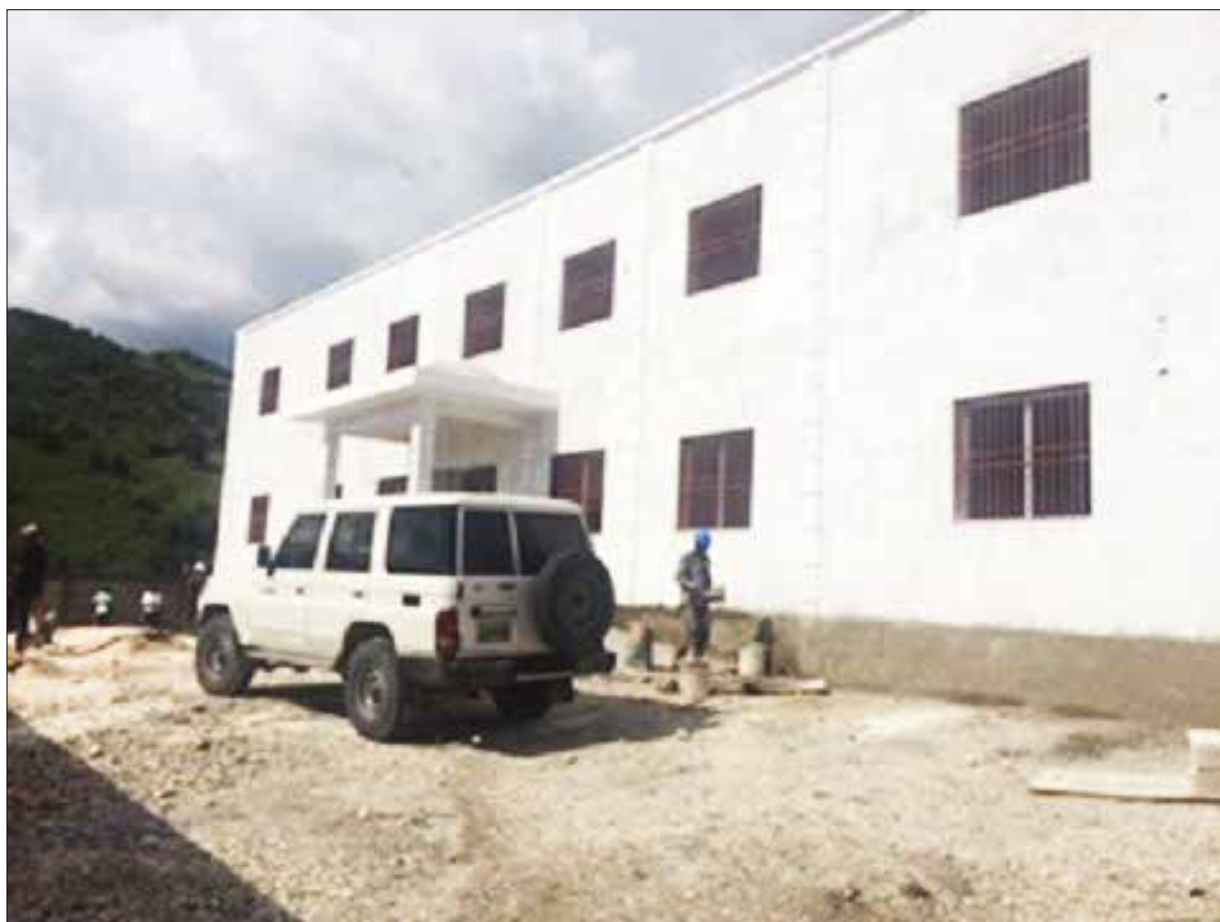
Construction du bureau sanitaire du Sud-Est
