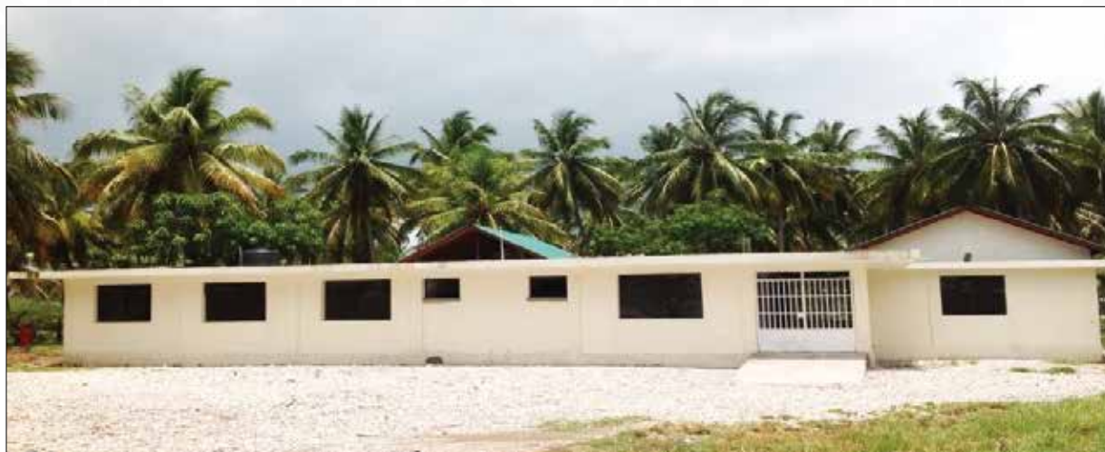
Construction du centre de santé de Dèyè Fò (Cayes)
