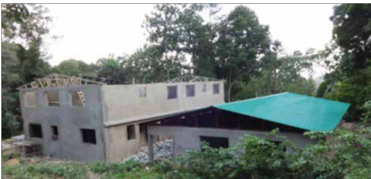
Construction du centre de Saut du Baril (Petit Trou de Nippes)
