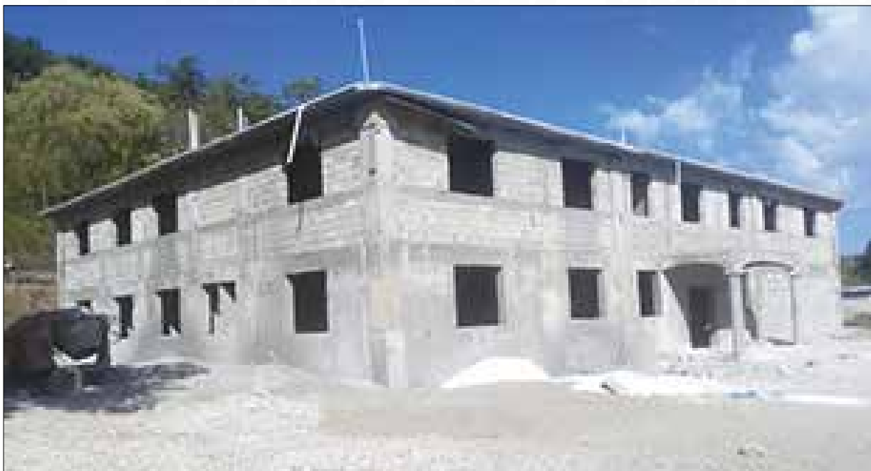
Construction du bureau sanitaire des Nippes
