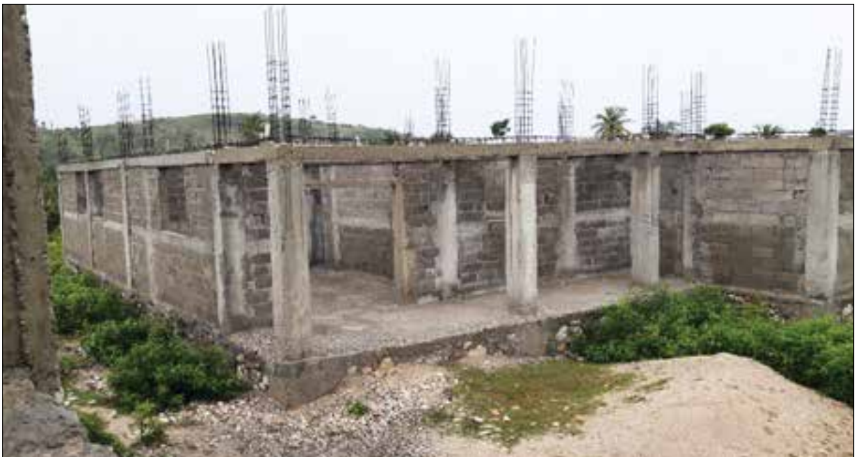
Construction du centre de santé de Roche à Bateau
