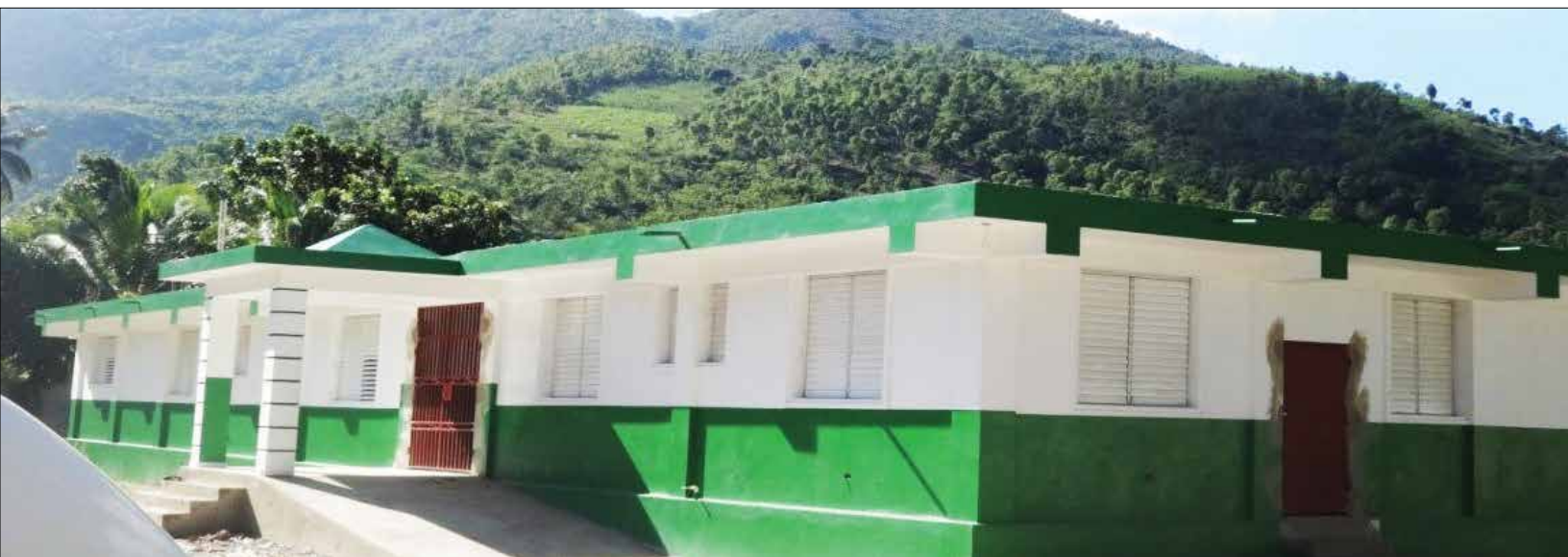
Construction du centre de santé de Baradères
