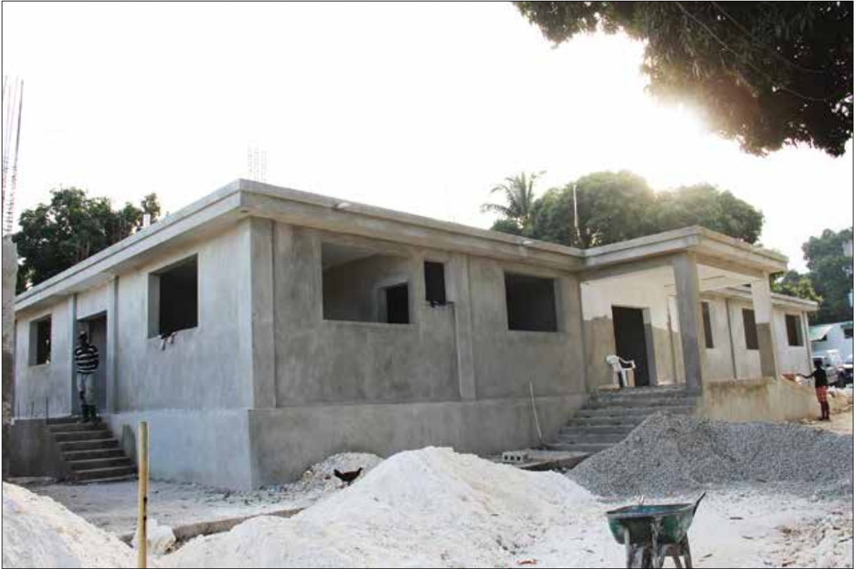
Réhabilitation des services de médecine interne et pédiatrie de l'hôpital de Petit Goave
