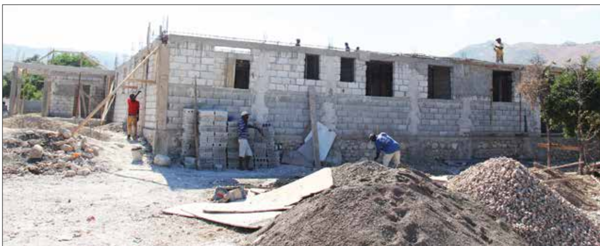
Construction du centre de santé de Petite Rivière Bayonnais (Artibonite)
