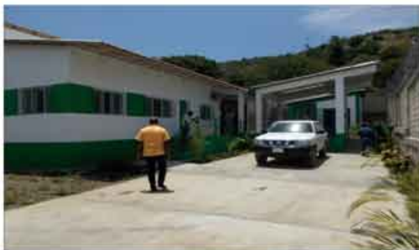
Construction CDAI de Miragoane – Financement Coopération Canadienne
