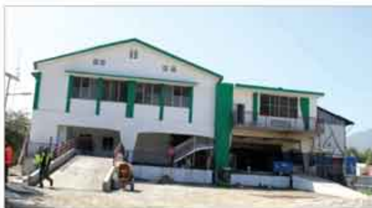
Construction Centre d'Urgence de Delmas 2- Financement BID
