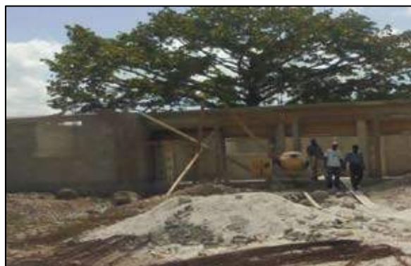
Construction du Centre de Santé de Lièvre (Petit Trou de Nippes) - Financement Eglise Catholique
