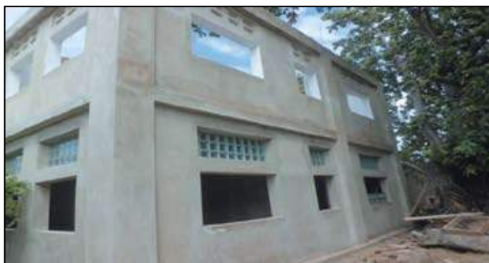
Construction d'une nouvelle maternité au Centre de Santé d'Anse à Pitres Financement: France- Architectes sans Frontières
