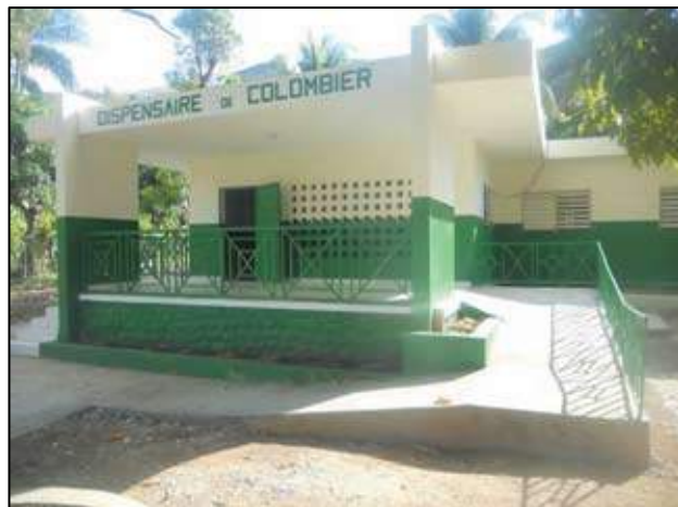
Réhabilitation du dispensaire de Colombier - Financement CECI
