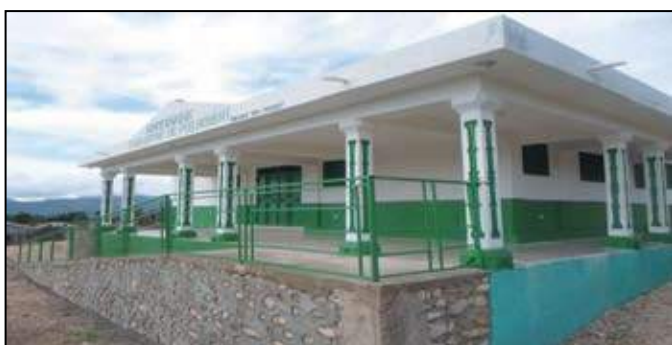
Construction du dispensaire T. Louverture du Puilboreau (Ennery) - Financement: Banque Mondiale/ Prodep (CECI)
