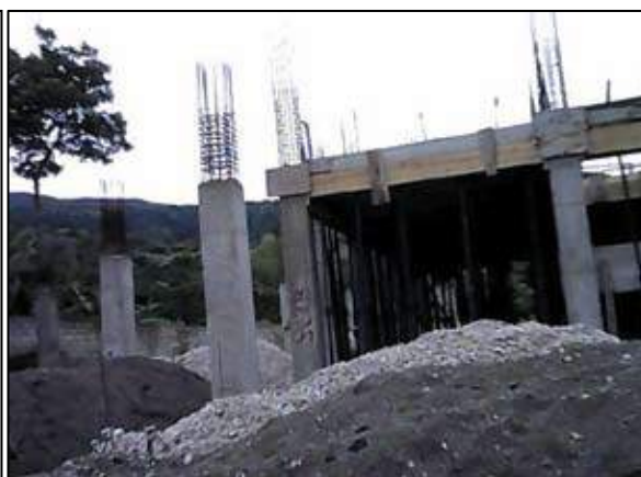
Travaux du Centre de Santé de Terre-Neuve (septembre 2014)
