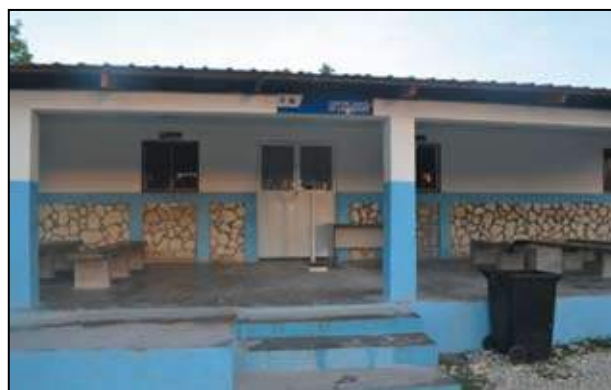
Réhabilitation du Centre de santé Liancourt (Verrettes)- Financement: Equateur
