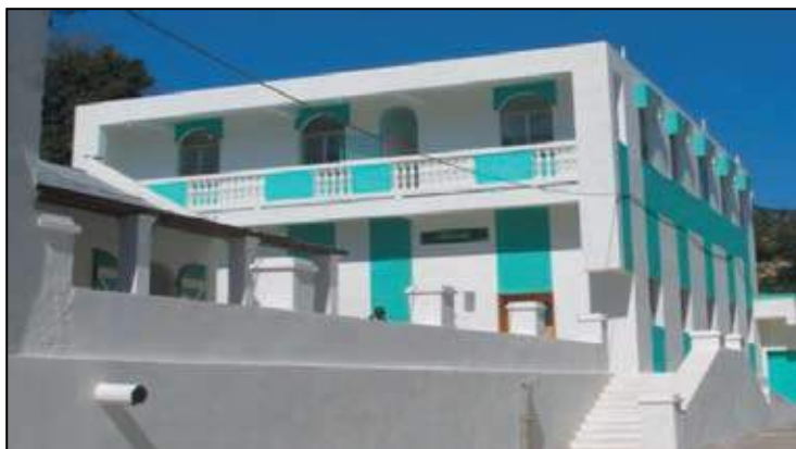
Réhabilitation du Service d'Urologie de l'hôpital Justinien de Cap Haïtien – Financement Trésor Public
