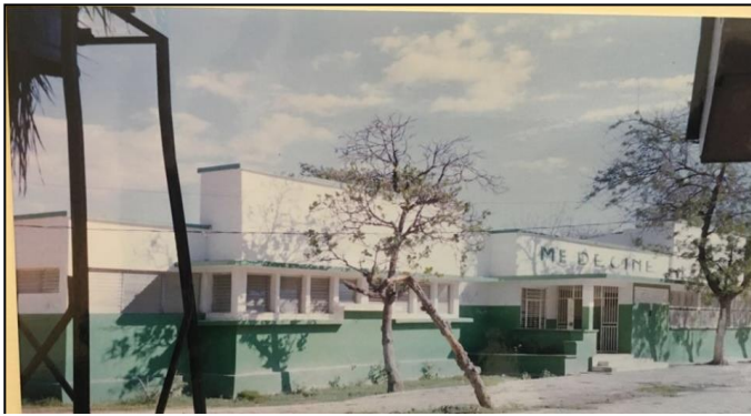
Figure 2- Ancien bâtiment de l'hôpital La Providence des Gonaïves
