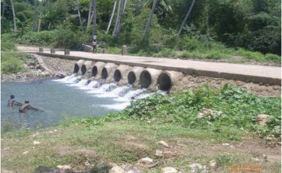
Photographie : Ponceau au croisement de la rivière Dame Marie
