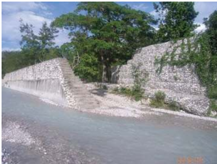
Point 83 : Ouverture entre les murs
