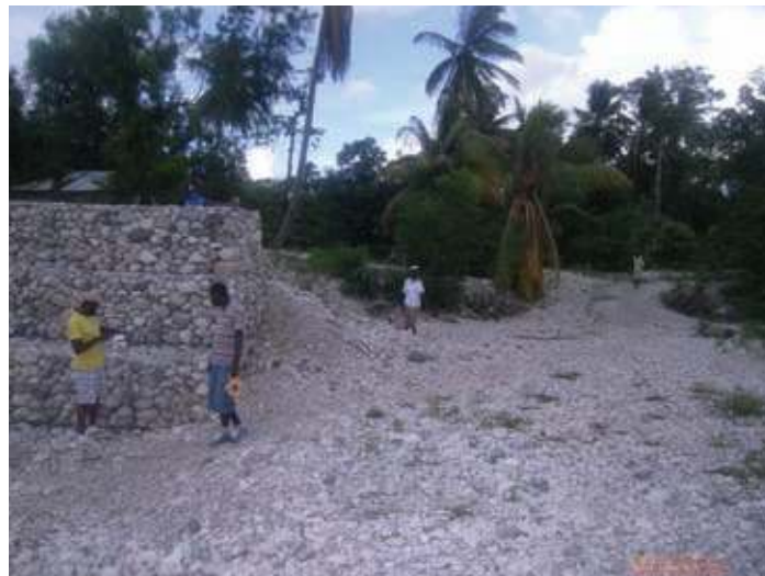
Point 84 : Limite du mur de gabions
