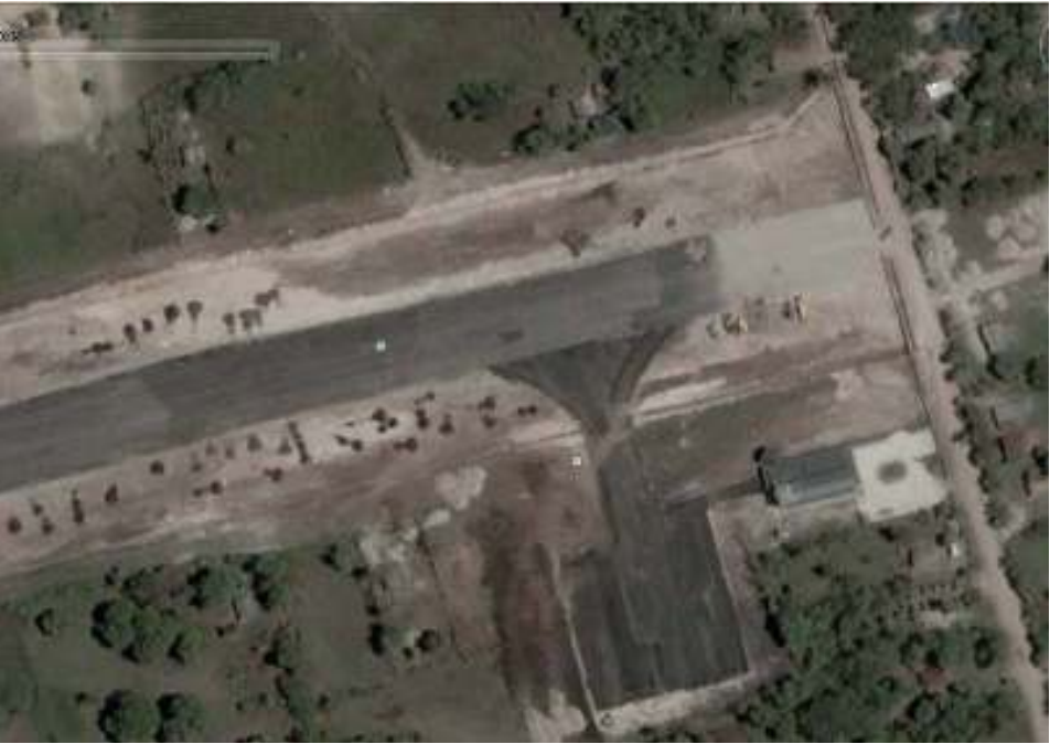
Photographie aérienne : l'aéroport des Cayes en construction (avril 2003)
