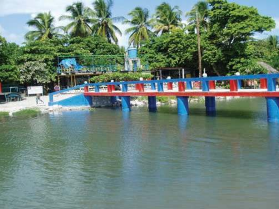
Pont pour piéton existant
