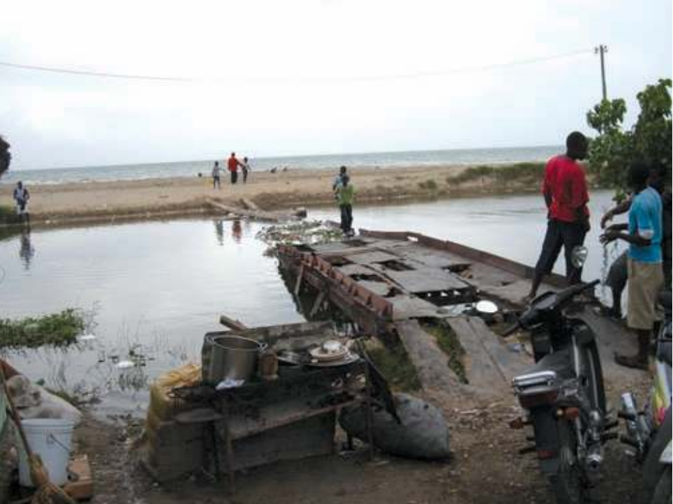
Pont piéton démol
