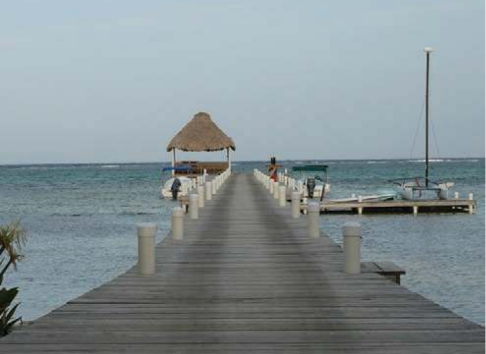
4 Exemple de ponton flottant
