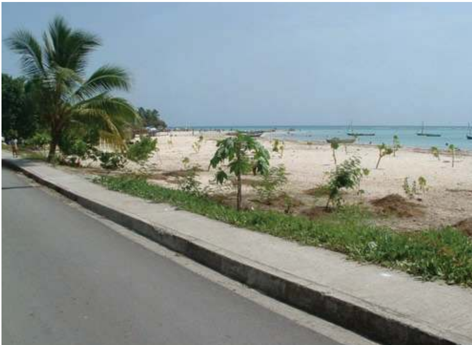
Photo 4 Rejet gravitaire de l'effluent du poste de traitement
