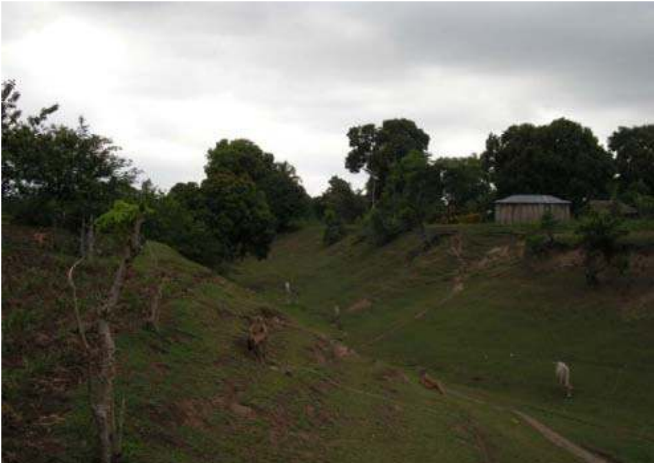
Photographie: Ravine Laval (Chaînage 0+2260)
