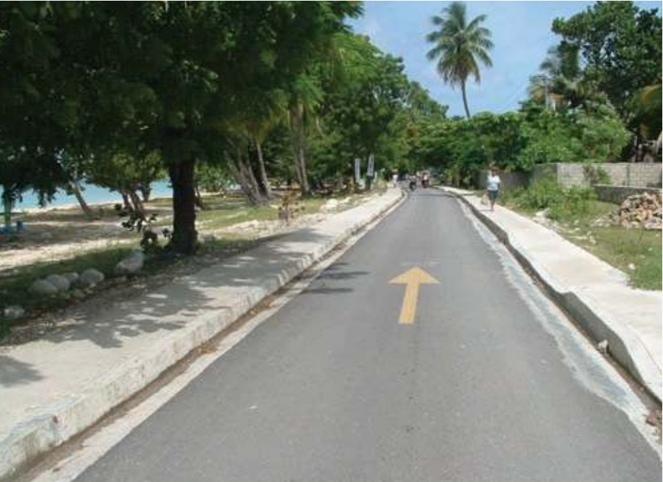
Photo 1 Espace disponible pour placer une conduite d'égout
