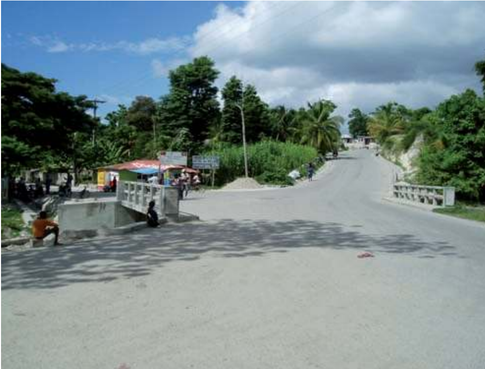
1 Pont boulevard J.J. Dessalines
