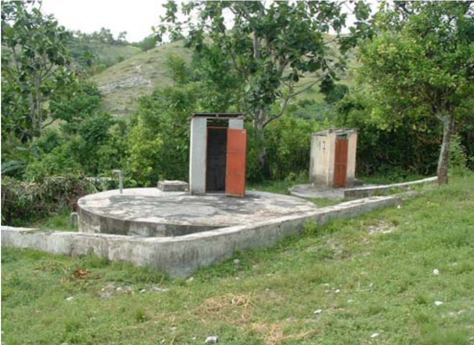
Photo 7 Réservoirs d'alimentation existants et site de la future usine de traitement
