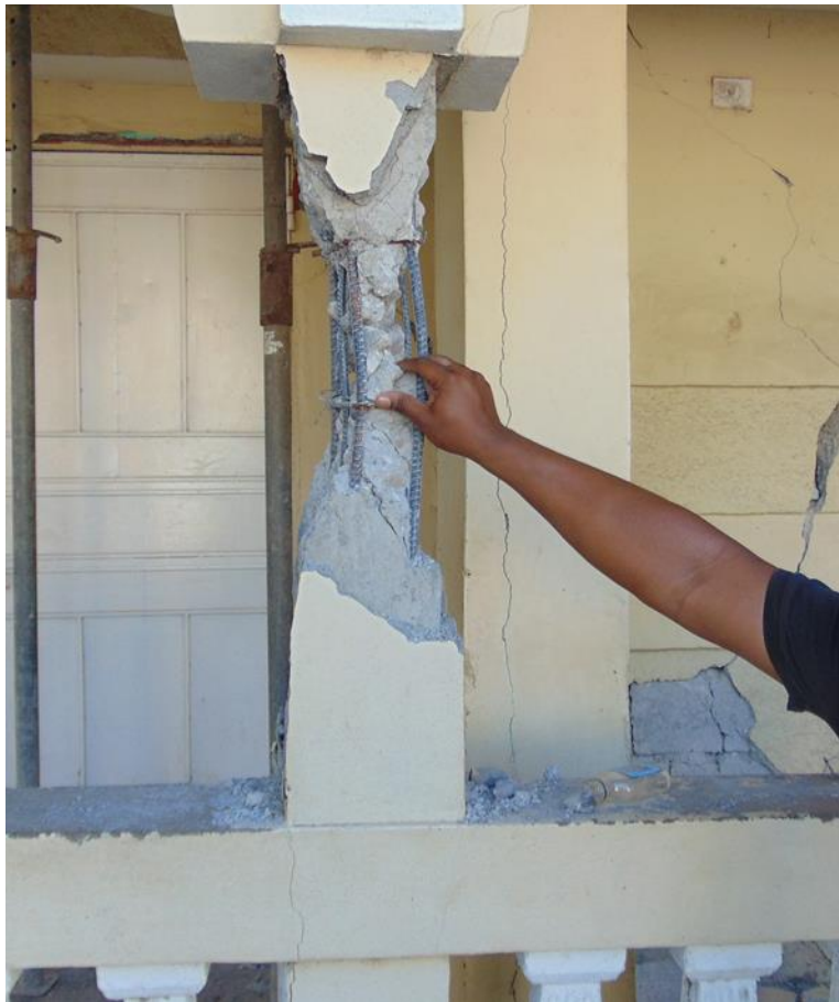
Figure H3. Exemple d'une colonne en béton endommagée
