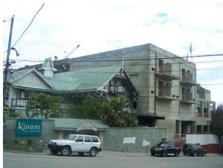
Projet de Construction en exécution Hôtel Kinam
