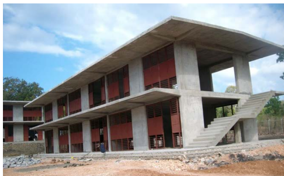
Modèle Béton Armé (BA), exemple en cours de construction
