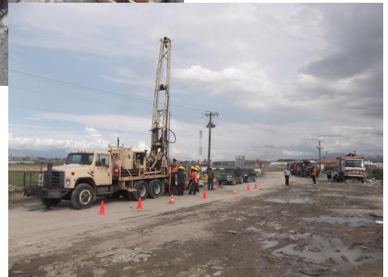
Techniciens en plein sondages géotechniques, Carribean Cement- Terminal Varreux
