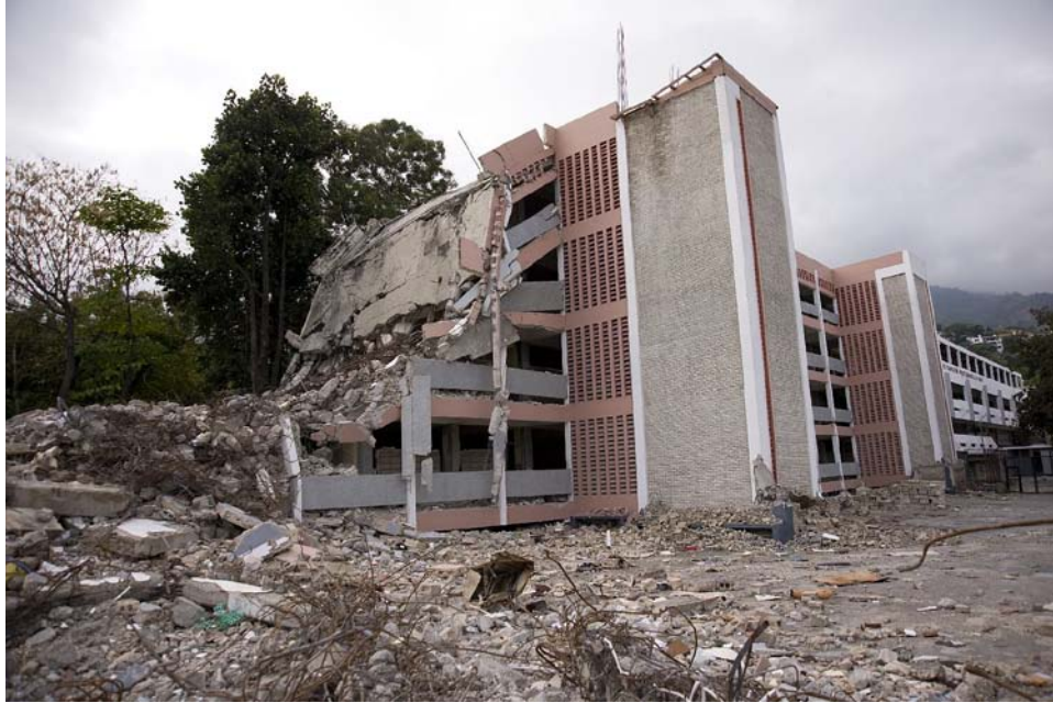
Figure 3. Effondrement du Collège Canado-Haïtien par écrasement du rez-de-chaussée : étage flexible et faible.
