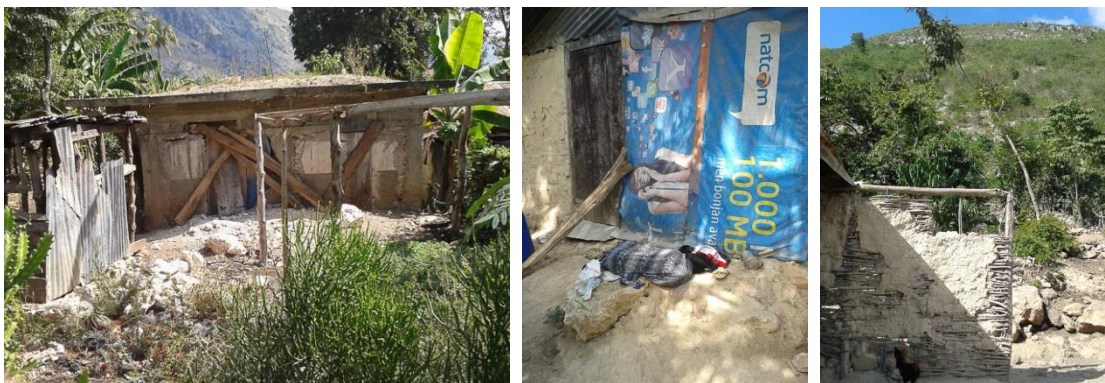
Figure 18 : Dégâts et blocs posés parmi les habitations au nord de la ville
