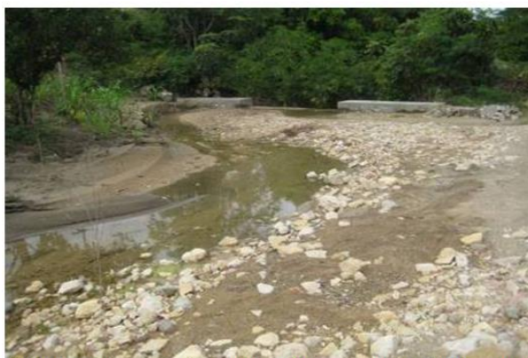
Photo 6. Remplissage complet du même seuil après un épisode cyclonique en 2008 (Source : SOS Enfants)
