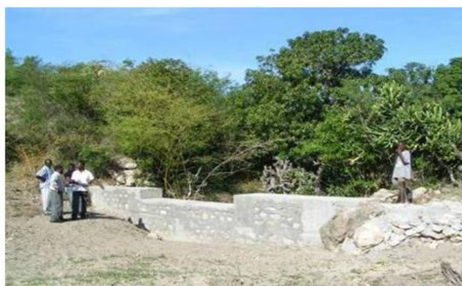
Photo 5. Seuil maçonné à Gros-Morne (Artibonite) au moment de sa construction en 2006 (Source : SOS Enfants)
