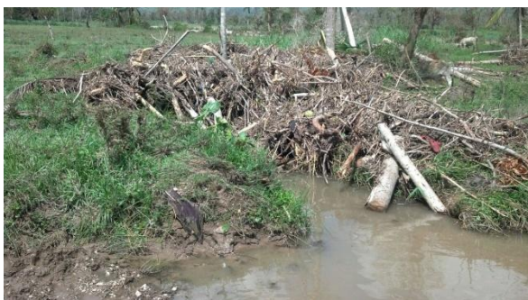
Image 9 : Canal d'irrigation enseveli sous des alluvions (Dory/Maniche)
