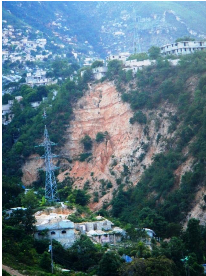
Figure 29 : Glissement Djobel 3 depuis le versant opposée. Source BRGM 2012
