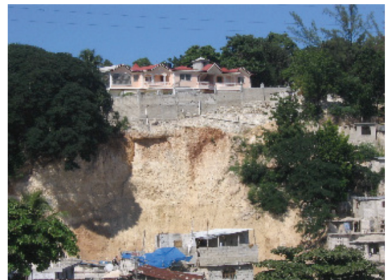
Glissement de Musseau en novembre 2008
