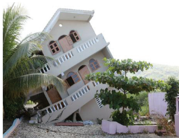
Effet de la liquéfaction - Exemple de poinçonnement du sol de fondation à Léogâne (Haïti), séisme du 12 janvier 2010 (M = 7.0)
