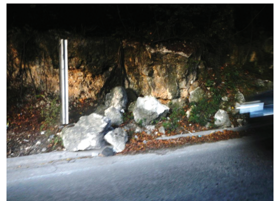
Chute de blocs sur la chaussée de la route Pan Américaine
