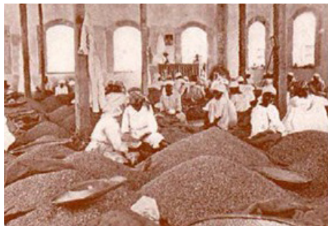
• Intérieur l'entrepôt J. B. Vital
