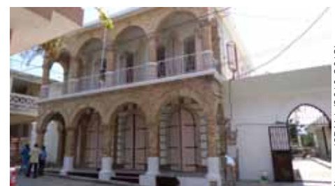
• Le Tribunal de Première Instance de Jacmel, avant et après restauration
