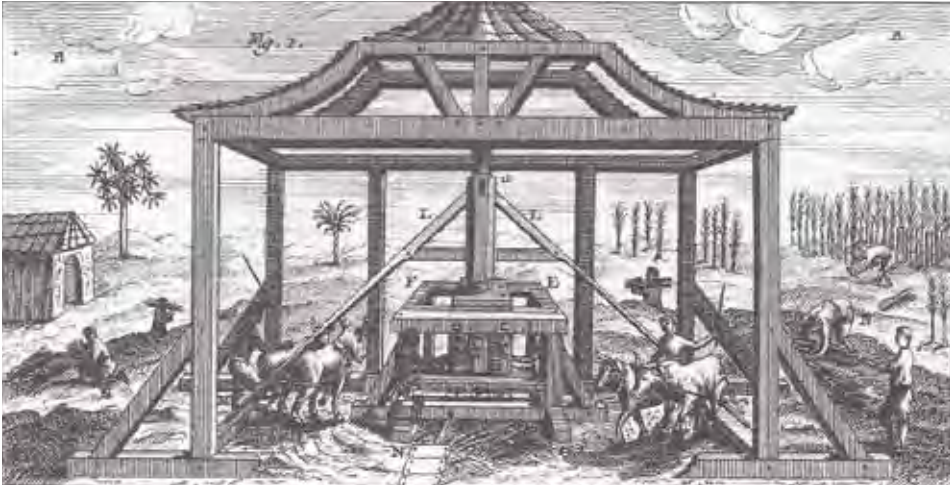
• Gravure illustrant le mécanisme du moulin à bêtes, tirée de l'Art de raffiner le sucre de Duhamel du Monceau (1780)
