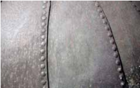
• Plaques métalliques rivetées de la chaudière
