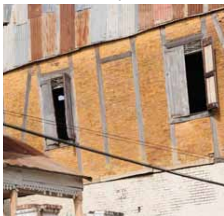
• Maison avec ossature en bois à remplissage maçonné (21, rue Destinville-Martineau, logeant l'Hôtel de Ville)
