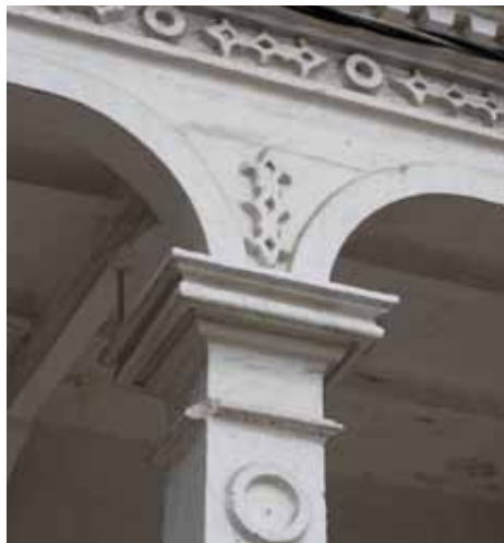
• Colonne en béton moulé dans un coffrage décoratif (77, rue Monseigneur-Beaugé • Architecte : Eugène Guilbaud)
