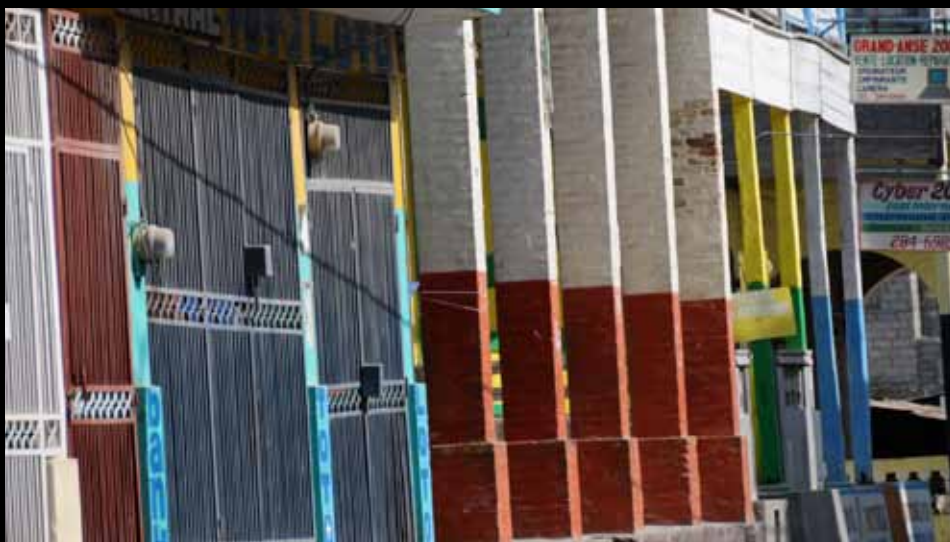
• Façades de la rue Eugène-Margron
