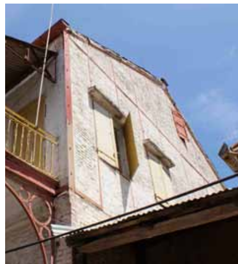
• Maison avec ossature métallique à l'étage (angle des rues Destinville-Martineau et Guerrier-Moussignac)
