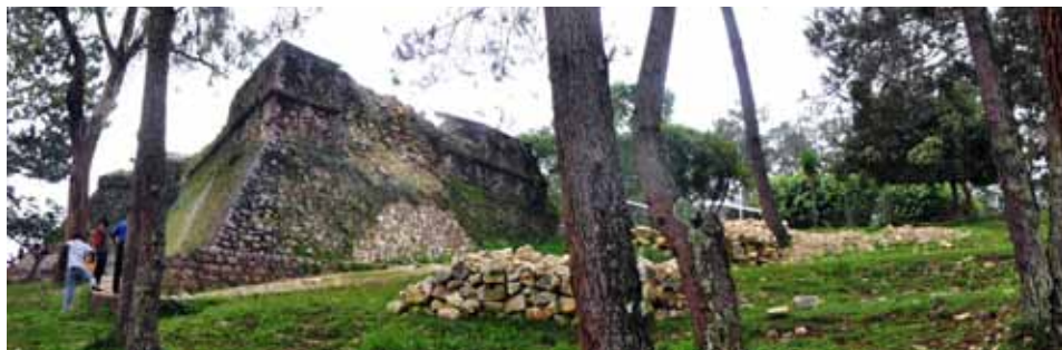
• Le fort Jacques nettoyé et les pierres récupérées, attendant les travaux de restauration
