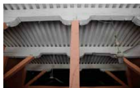
• Halle avec plancher en bois soutenu par un poteau et renforcé en ses extrémités de potences (100, rue Sténio-Vincent)
