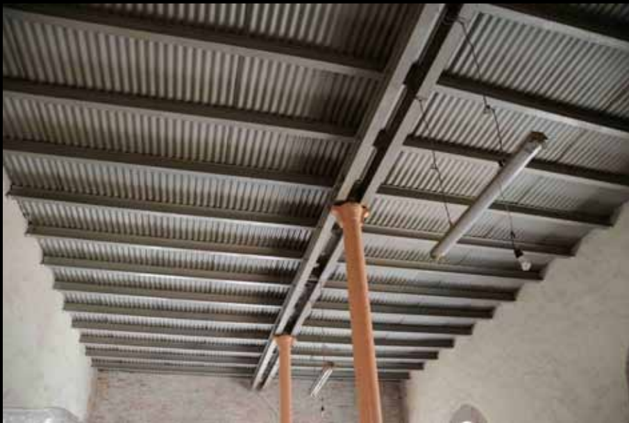
• Plafond de halle au 100 de la rue Sténio-Vincent
