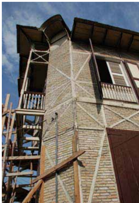
• 42 : Maison située au 32 avenue Lamartinière. La charpente en bois entretoisé et briques de hourdage est un élément important de l'architecture vernaculaire.
