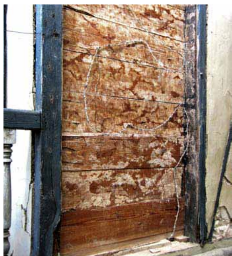
• 42 : Maison située au 32 avenue Lamartinière. La charpente en bois entretoisé et briques de hourdage est un élément important de l'architecture vernaculaire.
