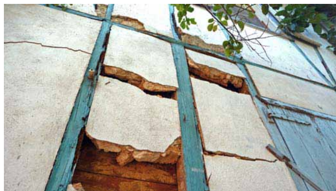
• 39 : Colombage au 5 de la rue José Martí avec hourdage de pierres calcaires et torchis de terre et un enduit composé de plâtre et de chaux. On remarque le revêtement intérieur en planches.
