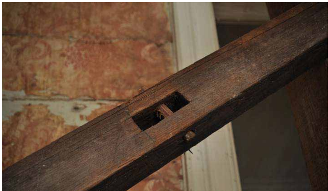
• 32-a : En haut : intérieur d'une pièce construite au-dessus de ce qui reste de la galerie de la maison Pamphile au 4 de la rue Casséus. L'intérieur montre les caractéristiques typiques en Haïti d'une construction en bois de charpente qui se situe quelque part entre les charpentes lourdes assemblées en tenon et mortaise comme dans les constructions en France de l'époque médiévale et de la Renaissance et les charpentes «à pans» de bois sciés plus légers des constructions américaines du XIXème siècle.
