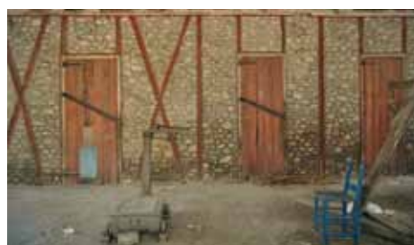
• 25 a : Grange à Léogâne. Exemple de colombage à moellons renforcé avec des roches ignées plus solides que celles utilisées à Port-au-Prince, et sans stuc.
