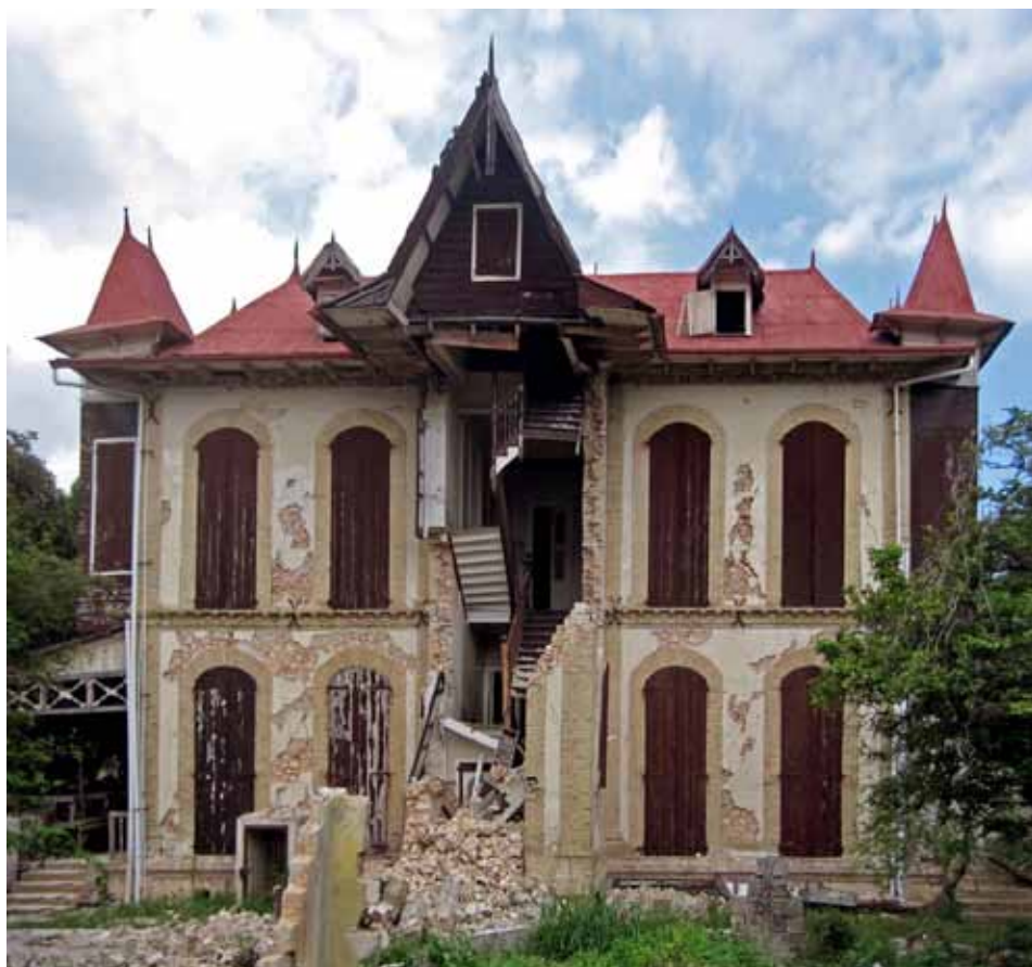
• 47 : Vue de l'élévation arrière du Castel Fleuri. L'utilisation d'une maçonnerie en briques autour des fenêtres, dans les angles et à la base du plancher, en tandem avec le stuc à la chaux qui recouvre ailleurs la maçonnerie de moellons, crée une attrayante composition. A noter les plaques de fond en X des tringles en fer visibles sur la façade qui, dans ce cas, n'ont cependant pas été installées dans les angles de l'édifice.
