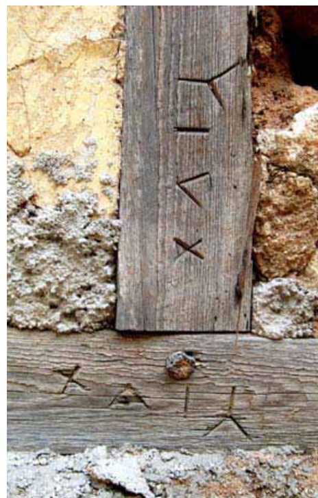
• 37 : Détail d'une maison à colombage. La charpente en bois est retenue avec une cheville de bois et les cavités des parois sont remplies de pierres et d'un torchis de chaux. Le remblai de gauche composé d'argile et de stuc est toujours en place. A noter la marque du menuisier gravée dans les bois de la charpente.
