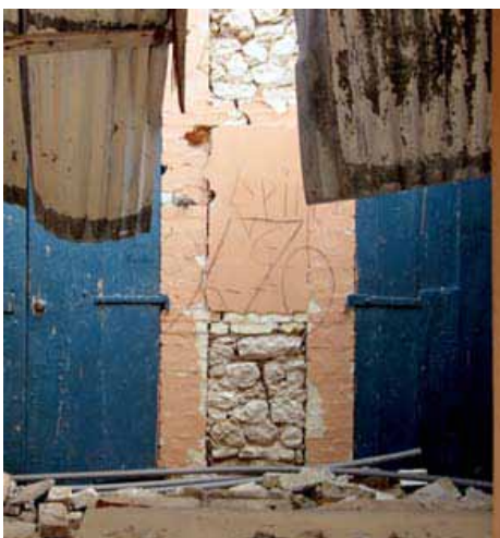
• 46 : Maison typique à «charpente en briques» avec hourdage de moellons.
