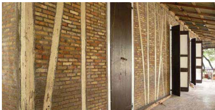
• 38 : Colombage avec hourdage briques et de torchis de chaux au 30 de l'avenue Lamartinière.
