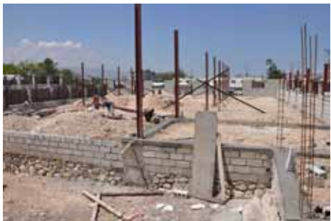
• Vues du chantier au mois de mars 2011
