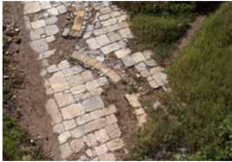
• Pavage en grès de Barzac des batteries
