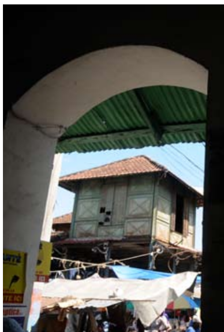
• Un des pavillons du Marché-en-Fer de Jacmel
