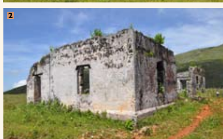
• 1. Le logement des esclaves domestiques de l'habitation Dion • 2. Ruines de la grand-case
