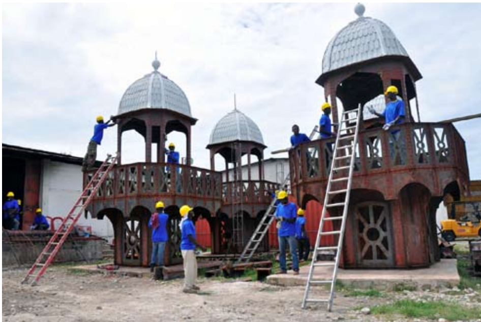
• Les travaux de décapage des tourelles du Marché Hyppolite
