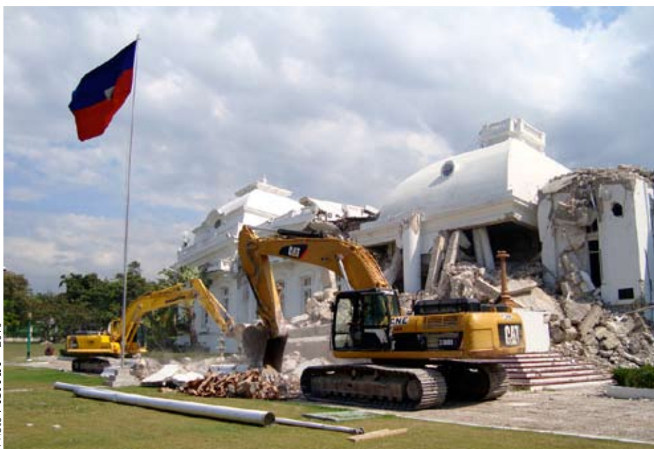
• Dépose des éléments irrécupérables
