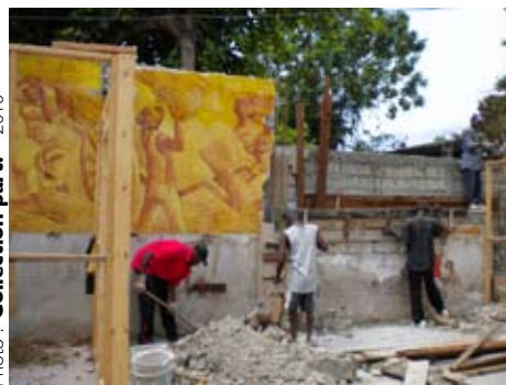
• La démolition de la fresque de Ramponneau
