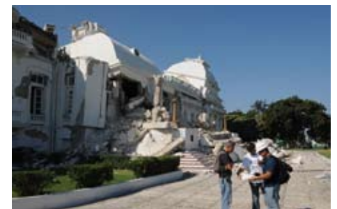
Visite d'inspection de l'ISPAN au Palais National
