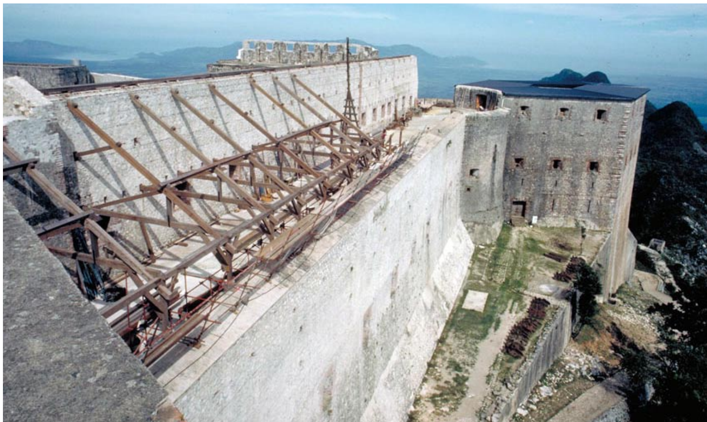
• Pose de la charpente de la Batterie Royale de la Citadelle Henry
