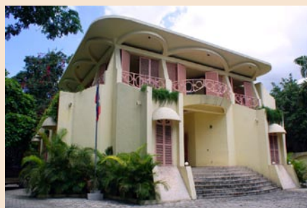
• Le bureau central de l'ISPAN à Port-au-Prince
