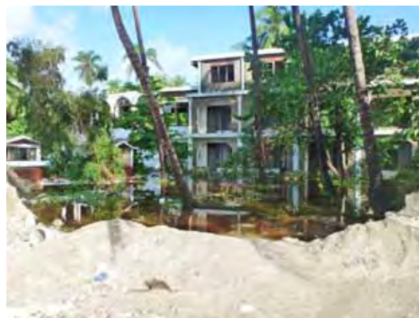
Drainage bloqué par le relèvement du bord de mer
