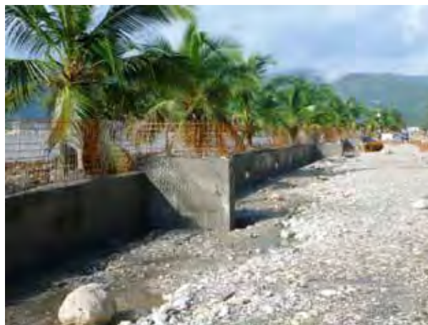
Mur de relèvement de la plage en cours de construction
