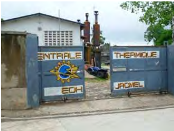
Centrale thermique de Jacmel
