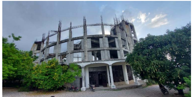
Nouvelle cathédrale en construction. Photo CIAT 2022
