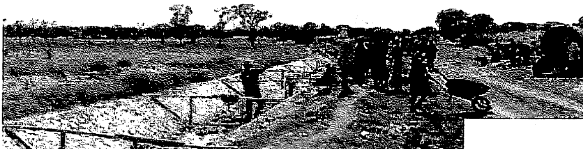
Travaux sur les canaux d'irrigation à St Raphaël
