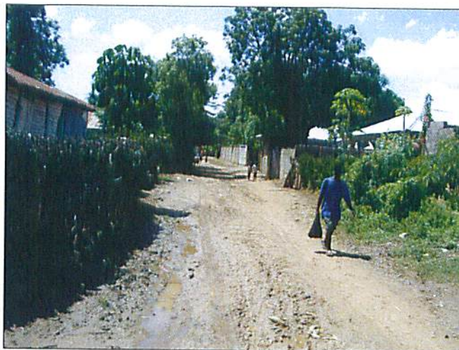
Photo 8: Réseau routier à réhabiliter
