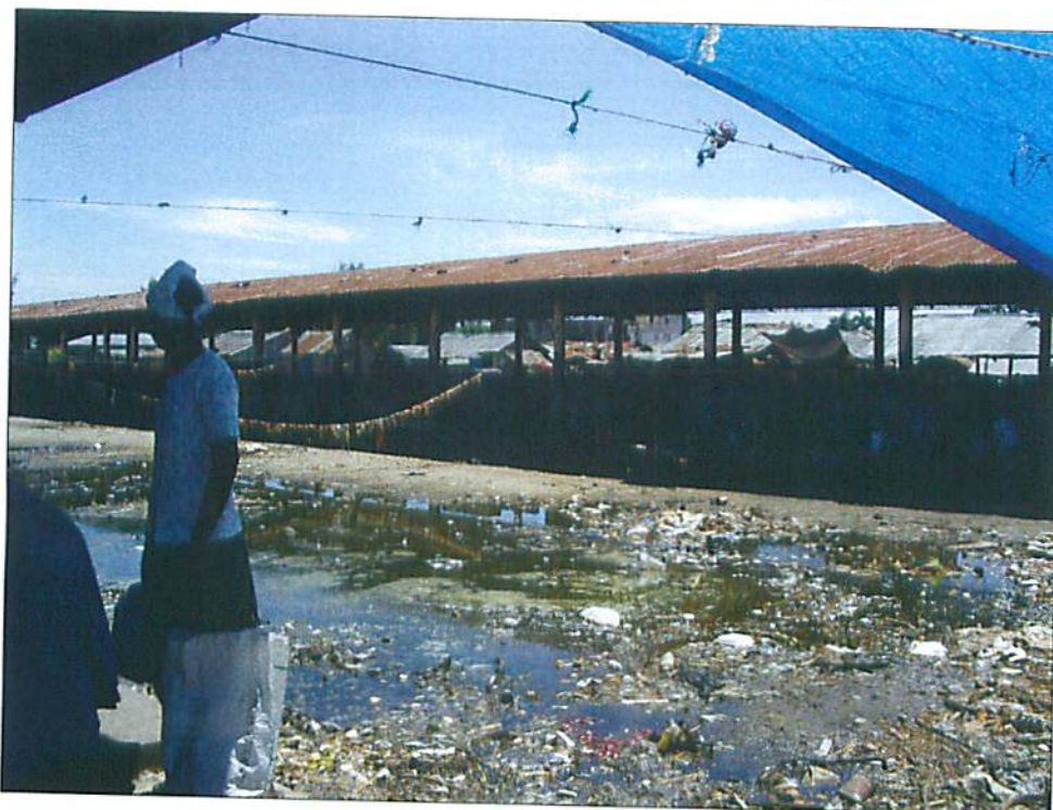
Photo 3: Problème de drainage aux abords du marché
