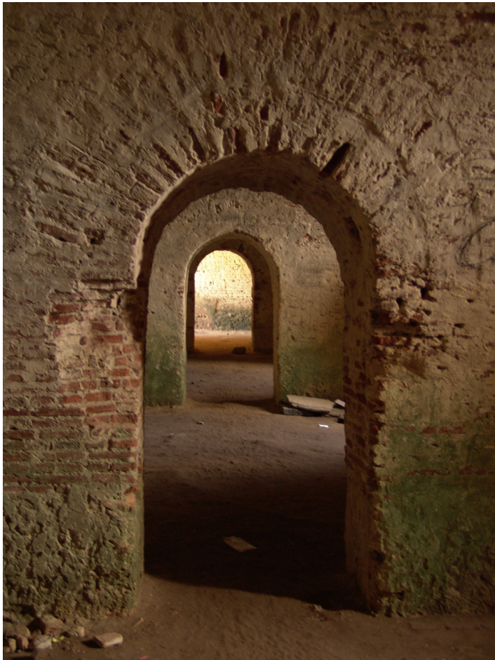
Salles voûtées du bastion de Maurepas
