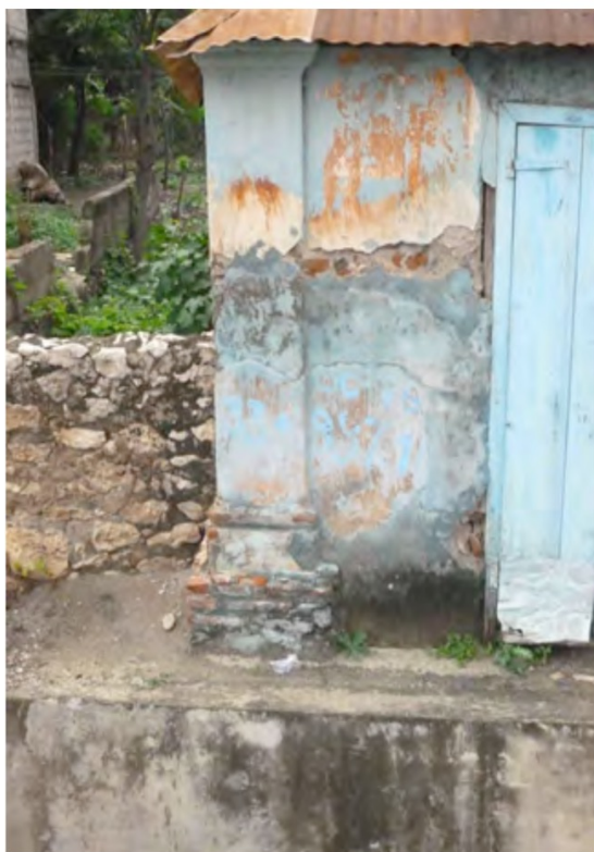
Détail pilastre d'angle
