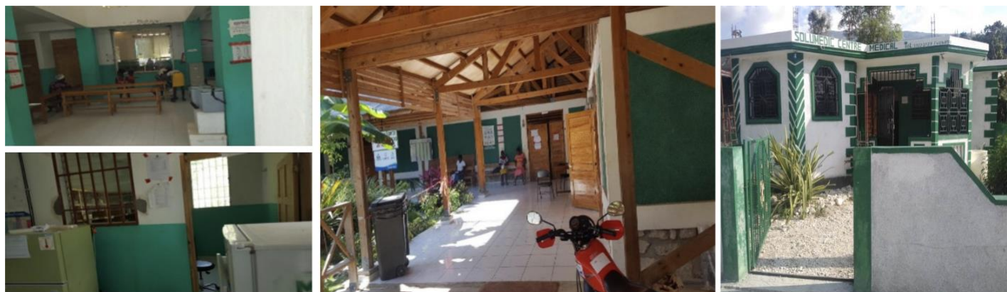
Figure 13 : Centre de santé à lits de Savanette (vue intérieure et extérieure)
