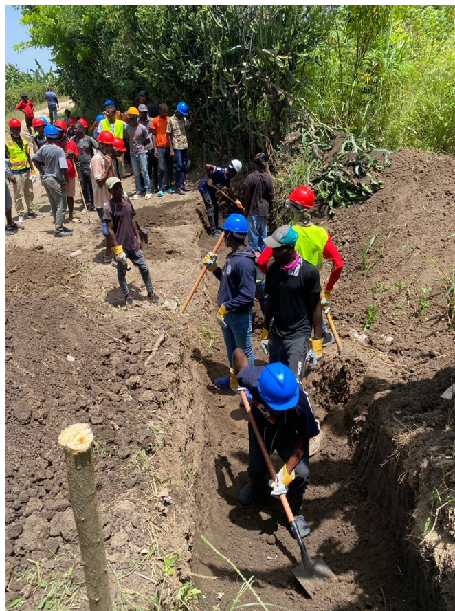
Figure 1 : Construction de 160 m 3 de gabions à Gros Morne-HA-J 0005
