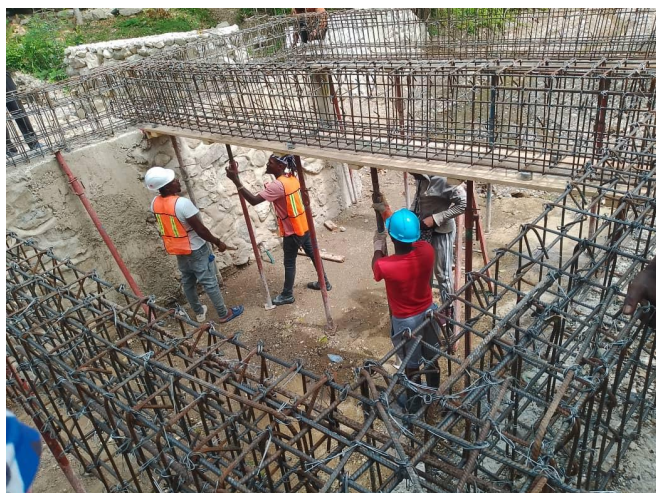
Figure 3: Réhabilitation du centre Professionnel de Kethan – Nippes - HA-J0007
