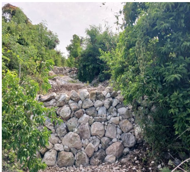
Travaux de correction de la ravine Ti Pierre Louis, Belle Anse, Crédit Photo Maxeau Jean Louis, Juin 2024
