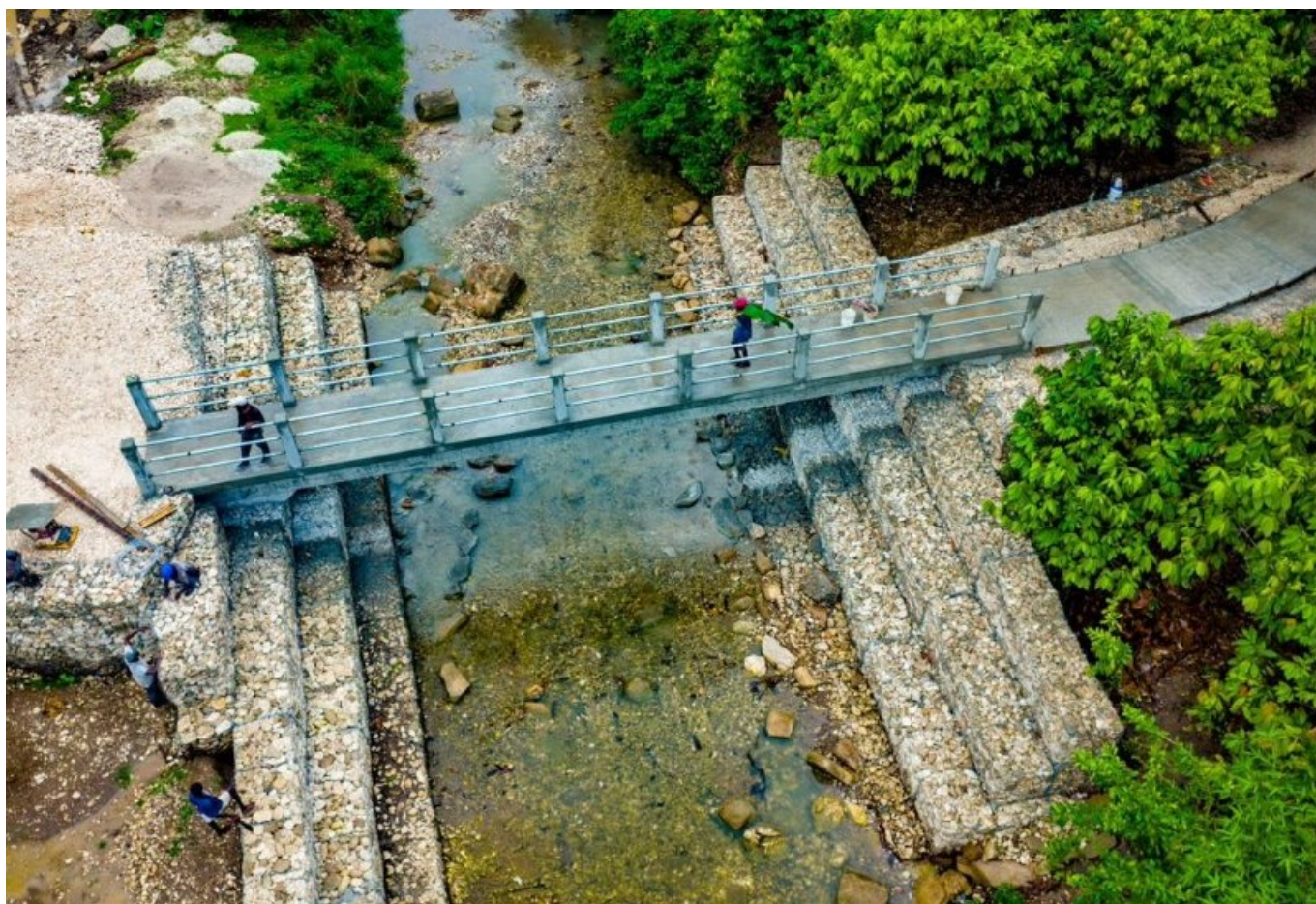
Construction de Pont facilitant l'accès des communautés aux marchés et des élèves à l'école
