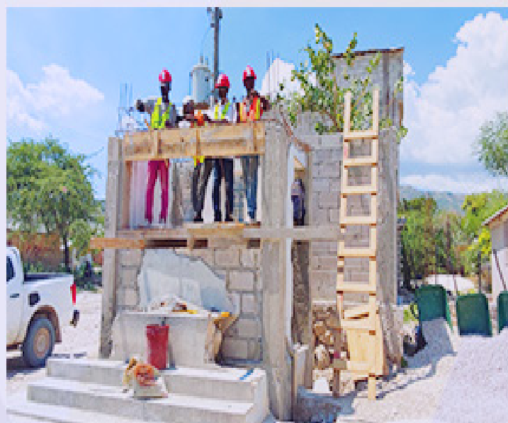
Réparation d'un Kiosque à Corail HA-J0005
