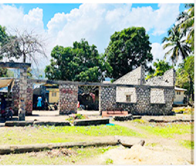
Projet de réhabilitation du centre professionnel de Kethan évalué / Nippes / HA-J00007
