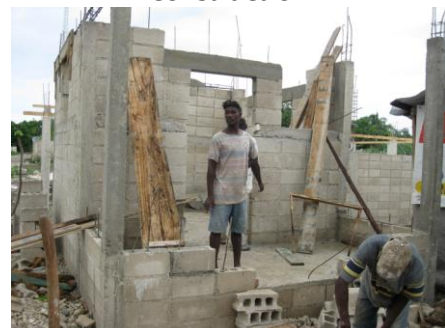
Kindergarten Belle Fleur en construction
