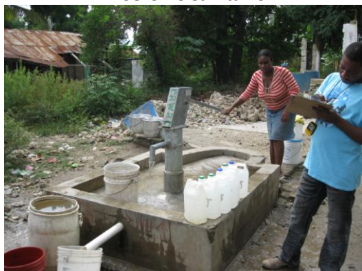
Pompe à piston de Grande Rivière : Problème sanitaire
