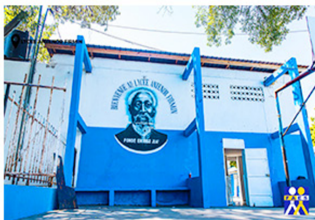
Réhabilitation du Lycée Antenor Firmin dans l'Ouest, AVSI
