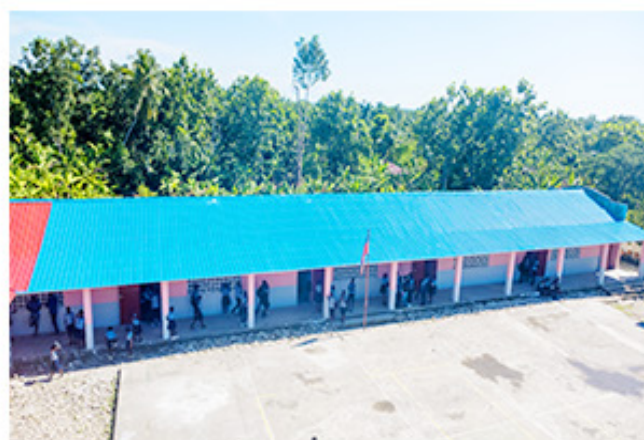
Réhabilitation de l'Ecole nationale d'Arniquet dans le Sud / AVSI
