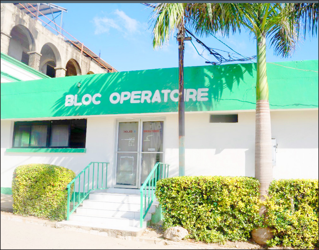
Une vue du bloc opératoire de l’hôpital Justinien à Cap-Haitien
