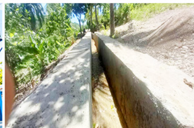
Réhabilitation de Canaux d'irrigation, Baie-de-Henne, Nord-Ouest , CARE
