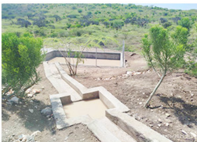
Construction d'un retenu d'eau à Baie de Henne, Nord-Ouest / CARE
