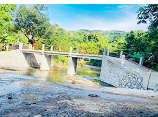
Construction d'une passerelle sur la rivière Médisant, Anse d'Hainault , Grand-Anse / PADF
